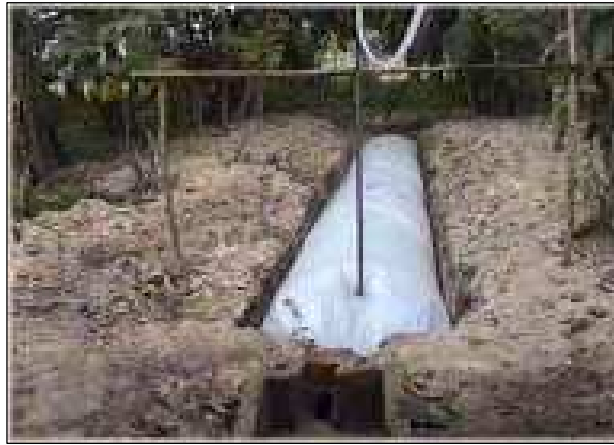
Figura 2.2 Biodigestor de polietileno ( Earth, 2003 )
