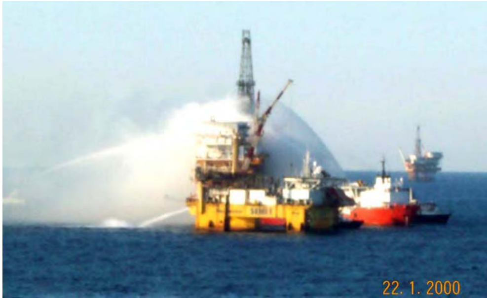
Figura 10. Plataforma de Inyección de Agua.
