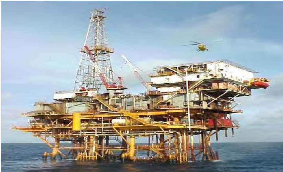
Figura 4. Plataforma de Perforación.
