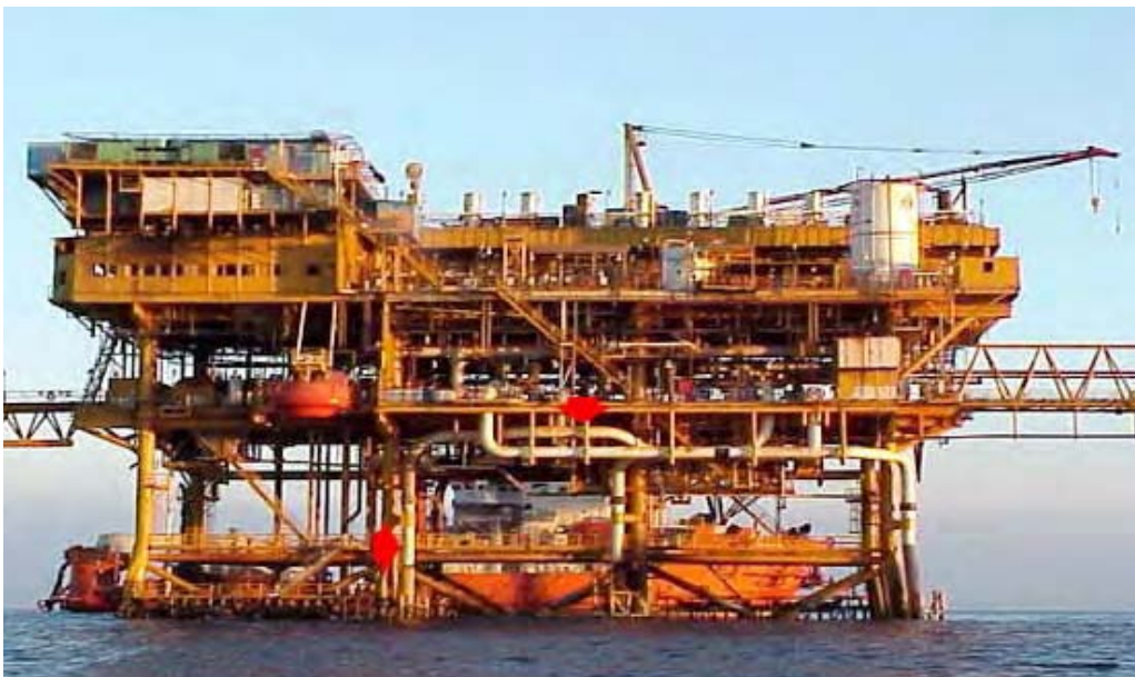
Figura 8. Plataforma de Rebombeo.
