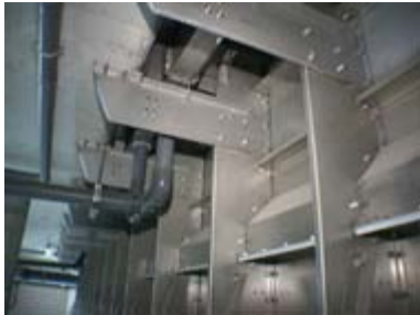
LOS PÁNELES SON REMACHADOS y fijados en su lugar mediante abrazaderas horizontales y verticales también de acero inoxidable grado S30400.
