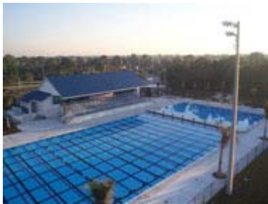
LAS ALBERCAS PÚBLICAS de Norte América han incrementado el uso de acero inoxidable para su construcción.
