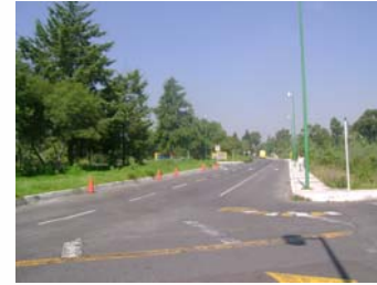
Vialidades, alumbrado público, energía eléctrica
