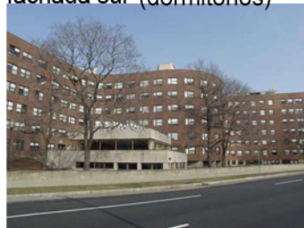
fachada sur (dormitorios)
