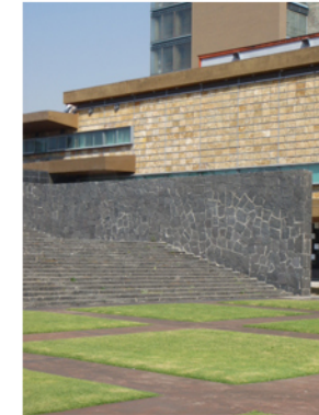
muro de piedra en la escalinata hacia Rectoría
