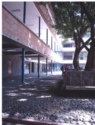
planta libre en la Facultad de Arquitectura
