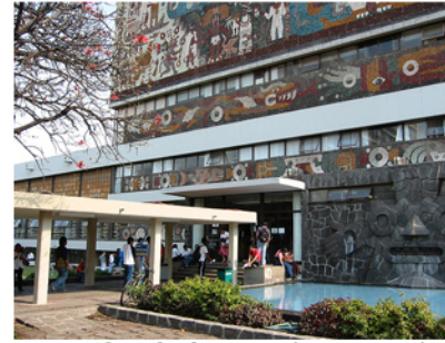
muro de piedra en el acceso de la Biblioteca Central
