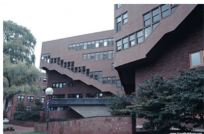
vista de las escaleras
