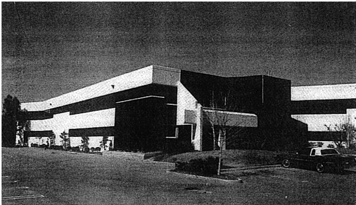
Figura 1.11 Nave Industrial Clarion, Queretaro, México.
