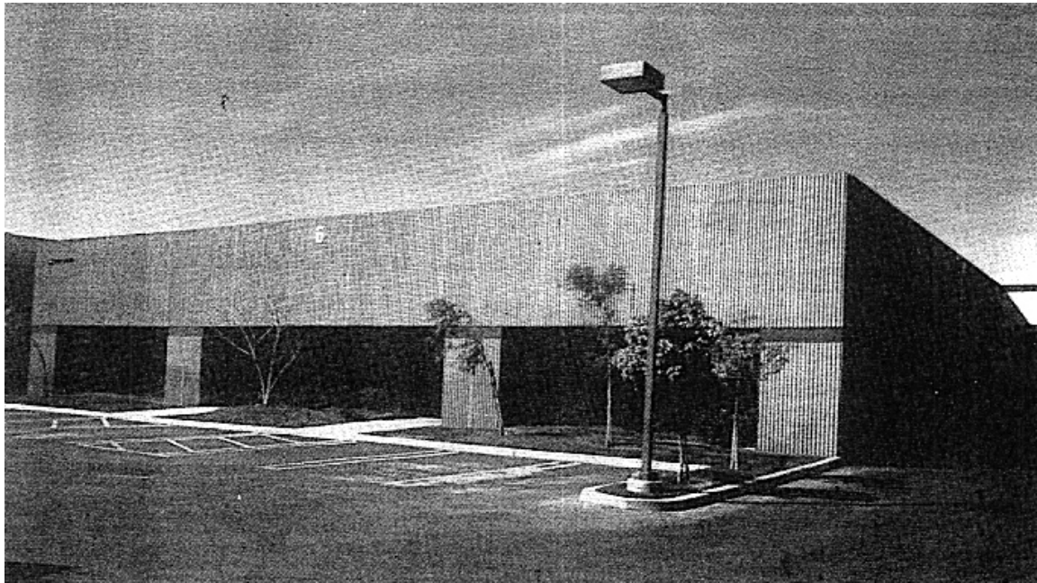
Figura 1.4 Nave Industrial Morton International.Toluca. México.
