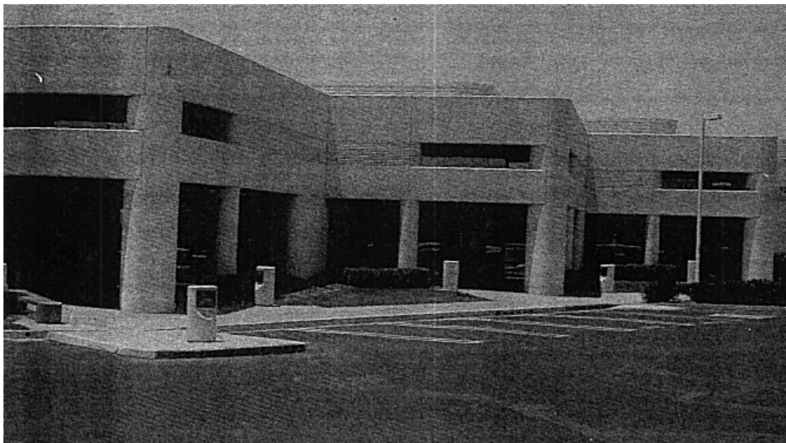
Figura 1.15 Edificio de Oficinas Sony, San Diego, California.
