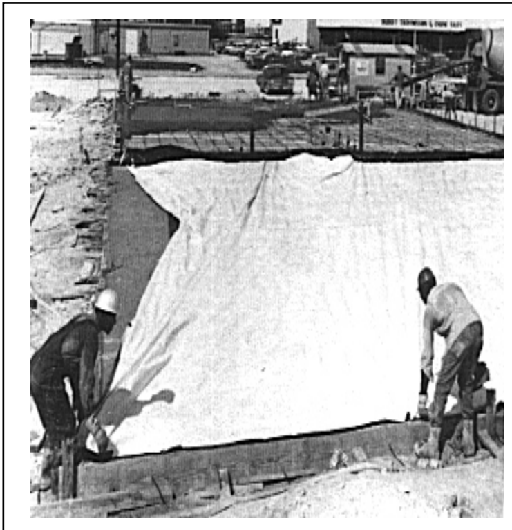
Figura 4.20b Colocación de cubierta de protección y curado.
