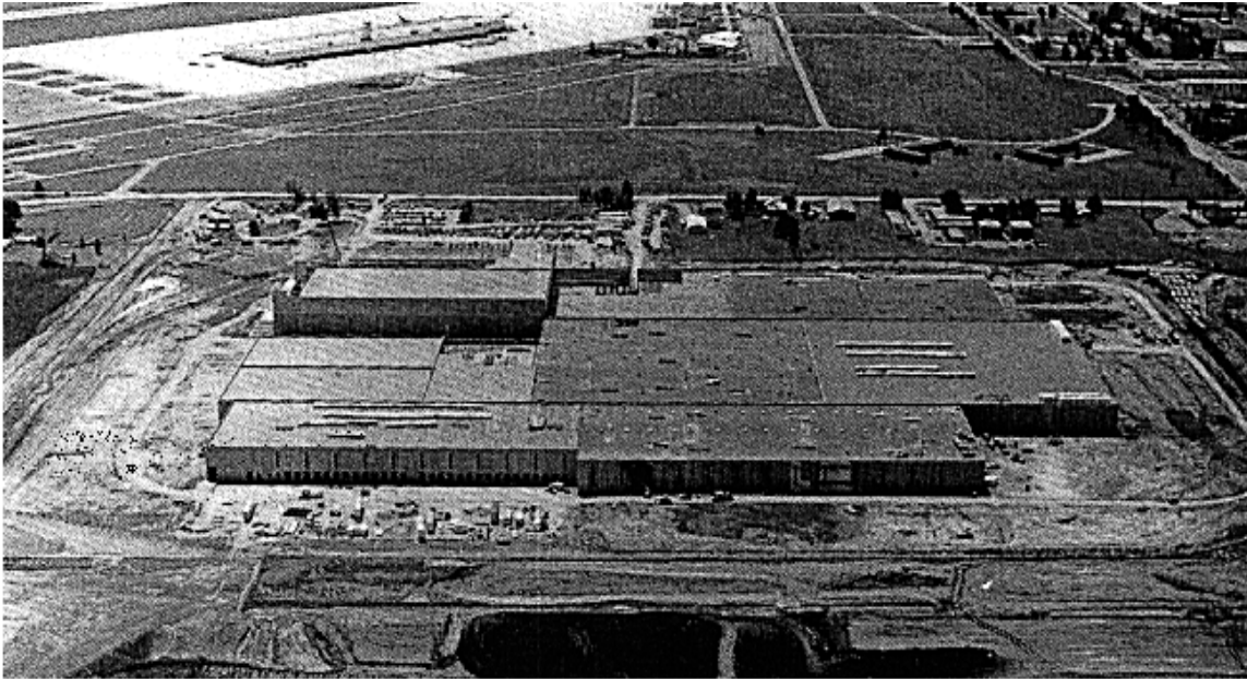
Figura 1.2 Nave Industrial Spieegel/Baur.Columbus. Ohio.
