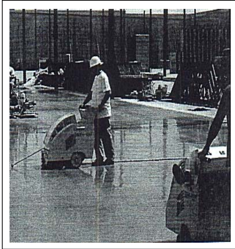
Figura 4.21 Corte de piso.
