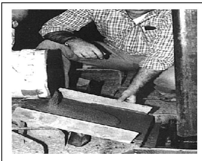
Figura 4.37 Grounteado de columnas.
