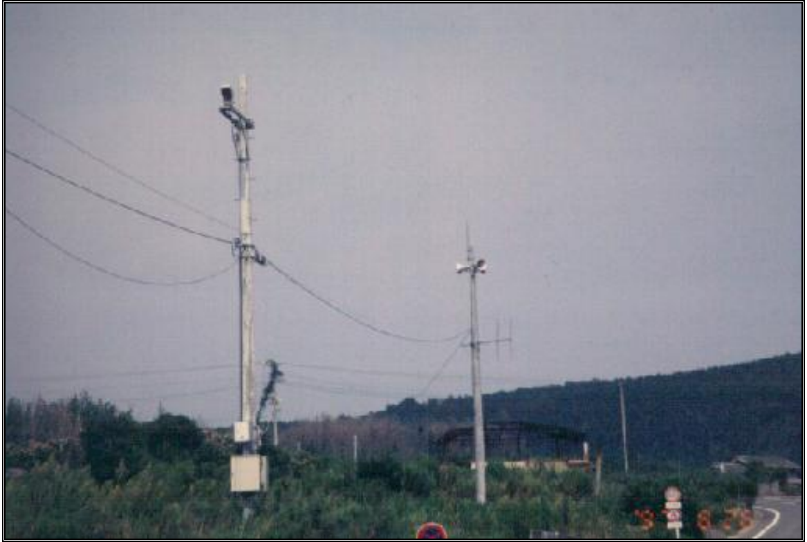
Foto 29. Altavoces colocados en lugares estratégicos, de tal manera que la población pueda escuchar claramente los mensajes de prealerta y alerta en caso de ocurrencia de flujos de lodo provenientes de la parte alta de un volcán (zona aledaña al Monte Unzen, Japón)
