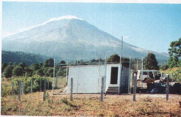
Figura 33. Caseta de protección en la estación Colibrí, Pue. (PPC) en la ladera Sureste del volcán. La caseta es de mampostería y fue construida por la Unidad de Protección Civil de Puebla. Está adicionalmente rodeada por una reja de malla ciclónica y una cerca de alambre de púas para impedir el accrecamiento del ganado, noviembre 1994.
