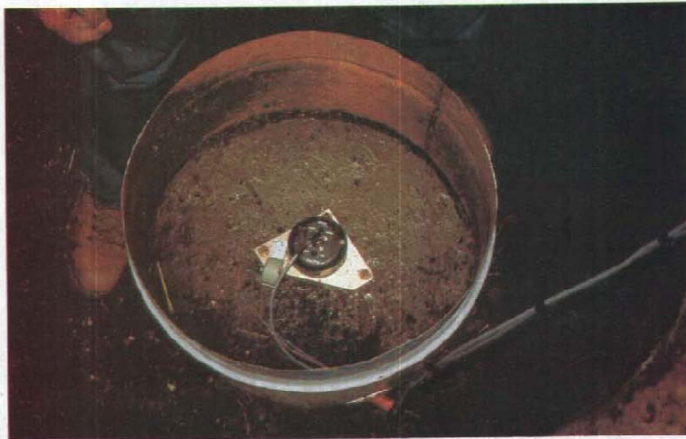
Figura 39. Vista al interior del pozo dentro del cual se instalaron los inclinómetros de baja y alta resolución en la estación PPX. Los sensores se colocaron sobre una base de concreto a 3m de profundidad y protegidos por un tambor metálico posteriormente cubierto de tierra.
