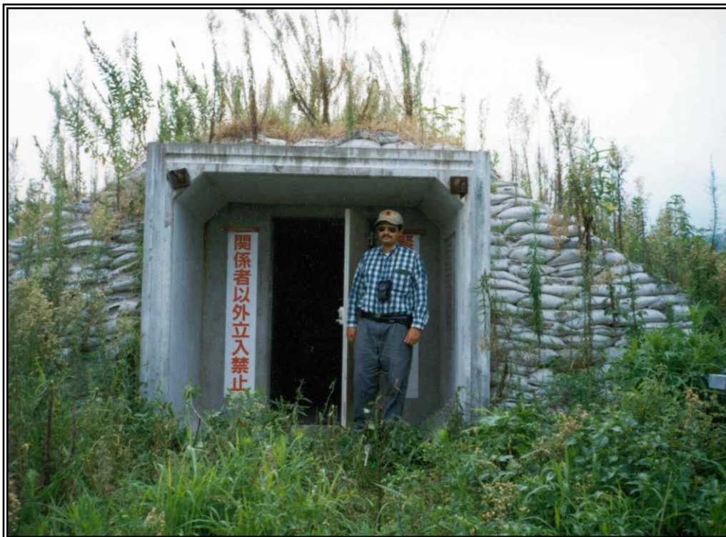
Foto 23. Refugio superficial para protección contra flujos y oleadas piroclásticas (Monte Unzen, Japón). Es importante contar con tanque de oxígeno en su interior para evitar la muerte por asfixia
