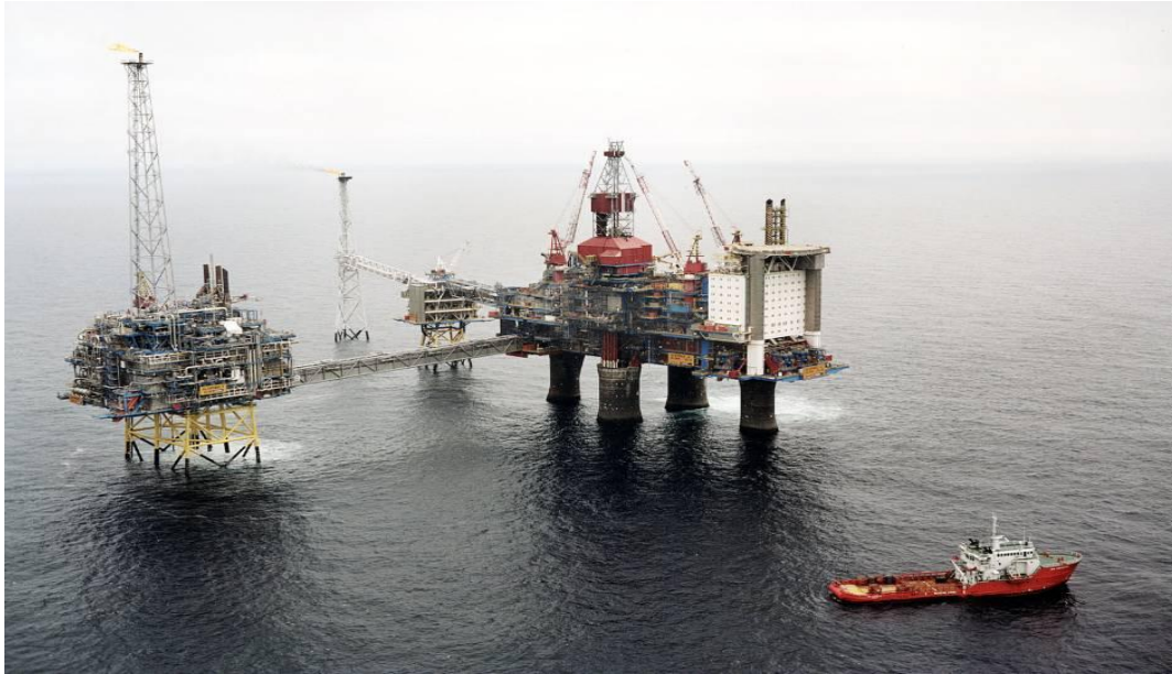
Figura 4.28 Plataforma de tratamiento de gas y plataforma Sleipner A 55 .
