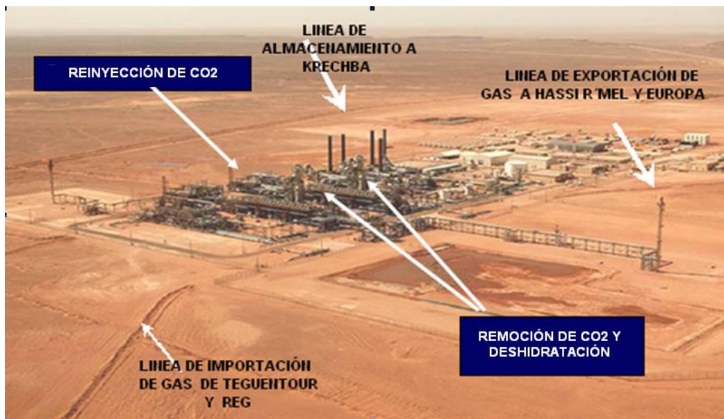
5.13 Planta de procesamiento de gas Krechba. 62
