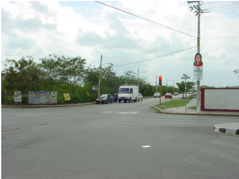
Figura 16. Cruce de Circuito Colonias y calle 28, área conflictiva en lo que se refiere al tránsito vehicular
