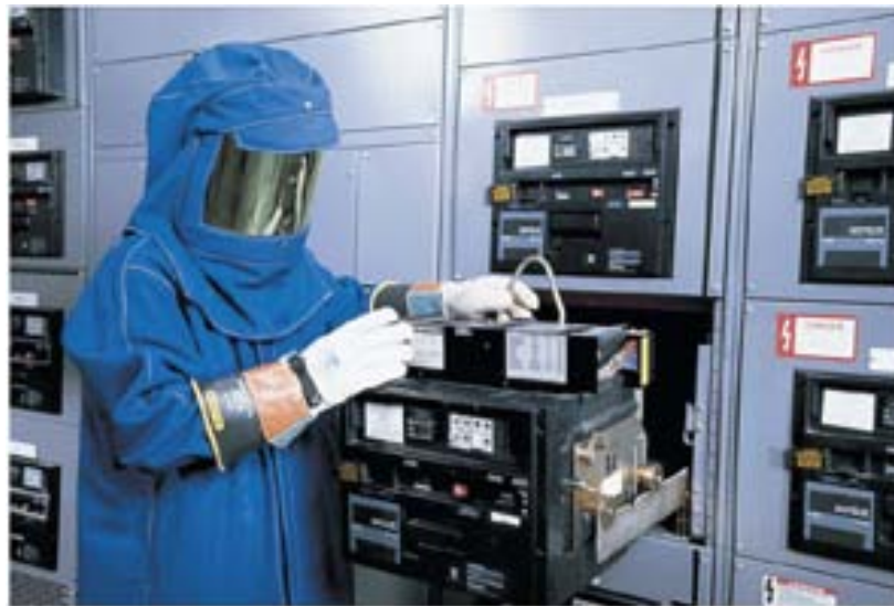
Figura 1.1. Personal de mantenimiento eléctrico utilizando el equipo de protección personal (EPP).
