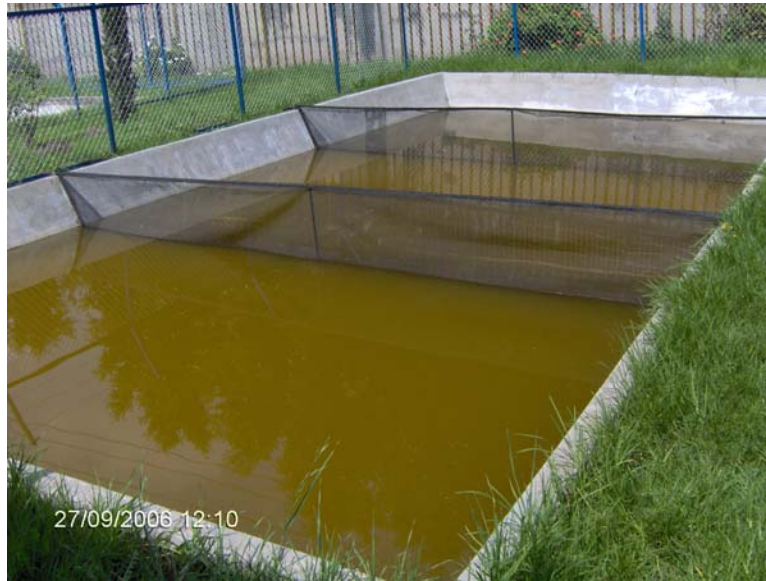
Figura 3. Estanque de cemento de la unidad acuícola experimental de la F.E.S Zaragoza
