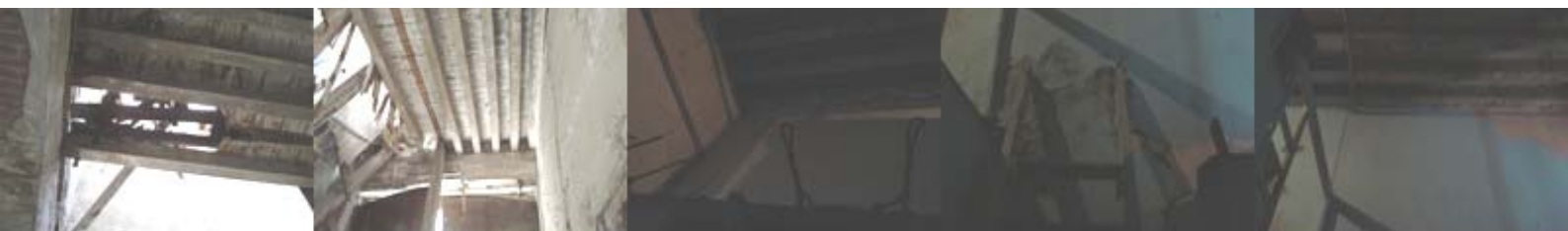
Vistas de la fachada del edificio desde el interior.
