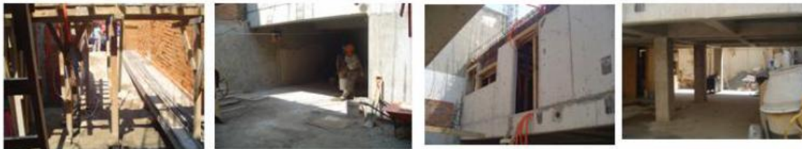
Panorámica del interior del terreno, donde se cuenta ya con avance de obra, cimentación terminada y estructura de semi sótano de estacionamiento, comienzan muros de primer nivel
