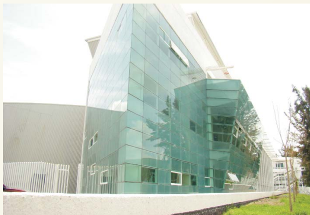
Foto 4.- Vista parcial del edificio de la FAUM, la imagen muestra la zona de Talleres y Administración. Ramírez M., 2008
