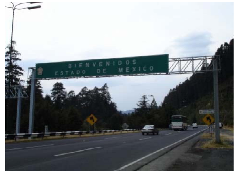
Autopista Constituyentes-La Venta-La Marquesa,(No.15D).
