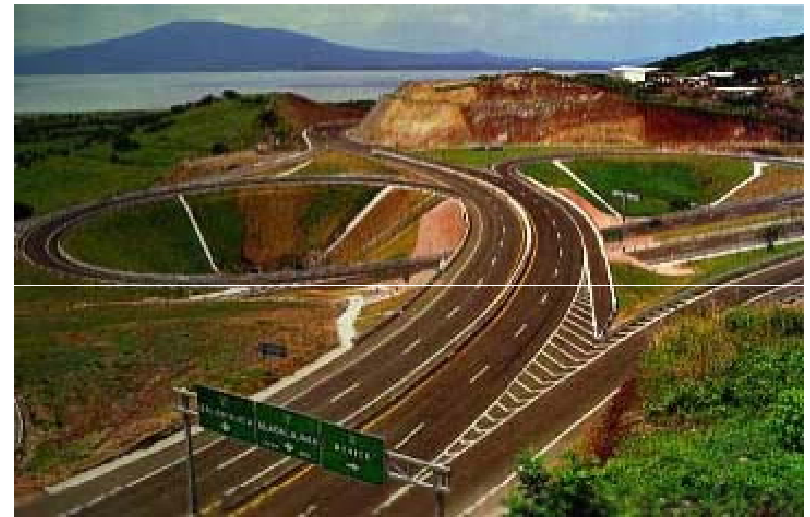
Autopista de Occidente (México-Morelia-Guadalajara). Entronque de Morelia, Michoacán.
