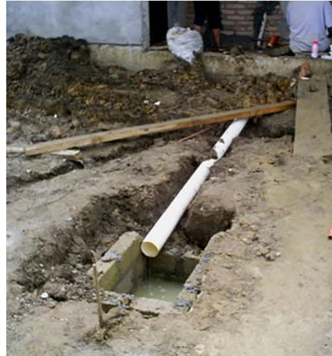
Fig. 24. Colocación de tubería de pvc
