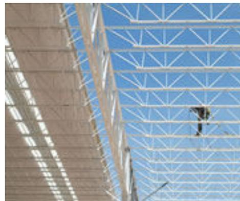
Fig. 26. Armadura de cuerdas paralelas
