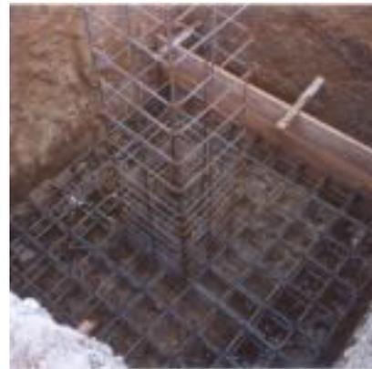
Fig. 27. Detalle de armado de zapata aislada
