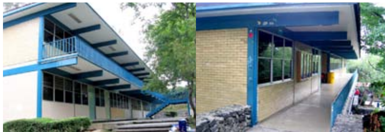
Grupo im. 4 En las fotografías se observan las vigas y columnas de las que están compuestos los edificios del plantel y sus amplias ventanas con molduras de aluminio.
