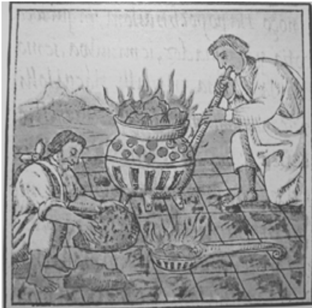
Imagen de orfebres prehispánicos fundiendo los metales en un horno portátil en el que se ve el material al rojo vivo en el interior, al que le tienen que insuflar el aire con la boca por medio de un carrizo imagen: códice Florentino
