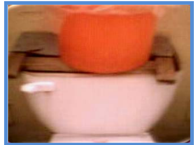
Fotografía 11. Tapa del depósito de agua sustituida por madera para evitar que el niño introduzca las manos.
