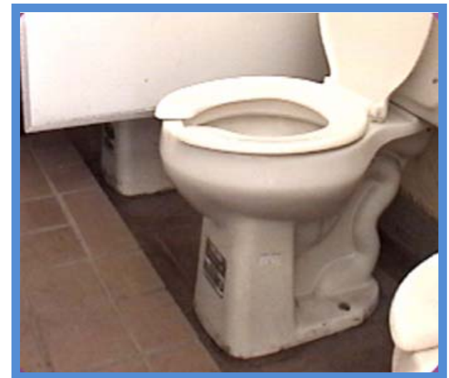
Fotografía 21. Desnivel de 12cm. para que el niño alcance a sentarse en el inodoro.
