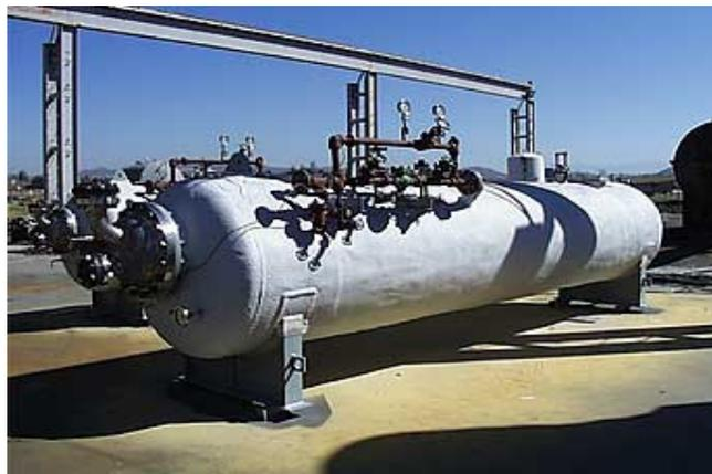
Figura 24. Vaporizadores de fluido intermedio con calentador a fuego directo
