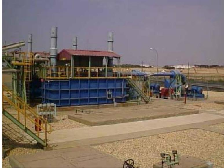
Figura 22. Fotografía de un vaporizador de combustión sumergida
