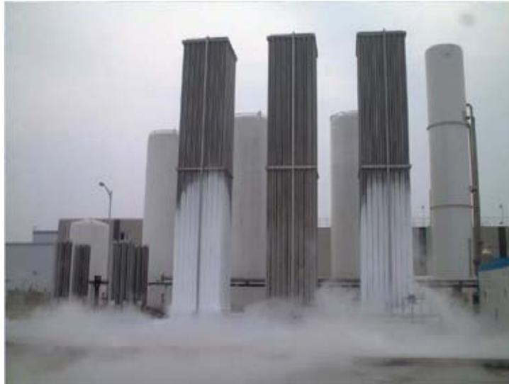
Figura 30. Fotografía de vaporizadores de aire
