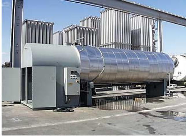
Figura 23. Fotografía de vaporizador de baño de agua.
