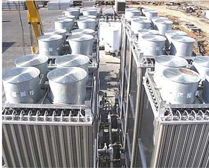
Figura 17. Vaporizador de aire ambiente de tiro forzado
