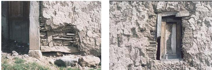
La construcción de una edificación de bahareque requiere de la cimentación, la estructura de madera, la estructura de entepiso, la estructura de cubierta, cubierta, el relleno, el enlucido y los acabados de pisos y paredes.
