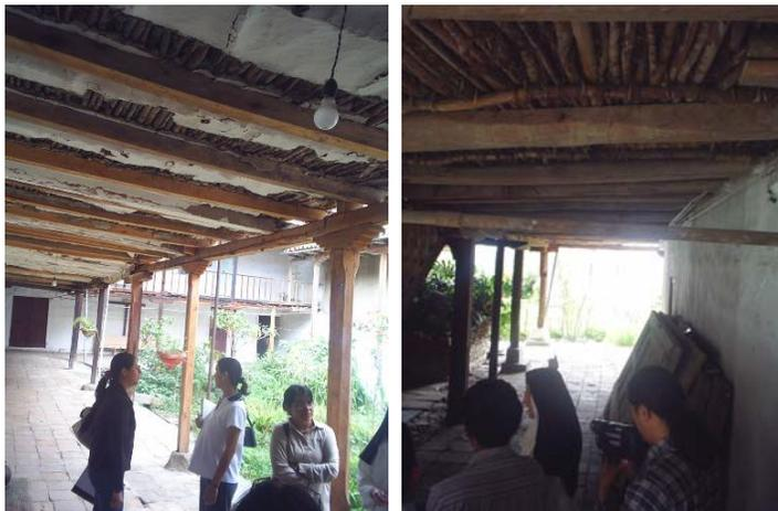
Los apoyos aislados, que conforman la estructura principal aporticada del edificio, en su mayoría se detectan, fisuras grietas, fracturas, xilófagos, torsiones, pandeos, humedades y faltantes como en el caso de la no presencia de capitel o montera. Existe el reemplazo total de los pies derechos en uno de los bloques que fue afectado por un incendio a los que se deben identificar para diferenciar de los originales.
