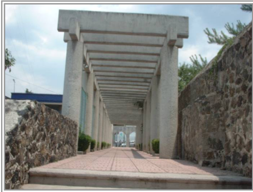
Vista interior del acceso secundario
