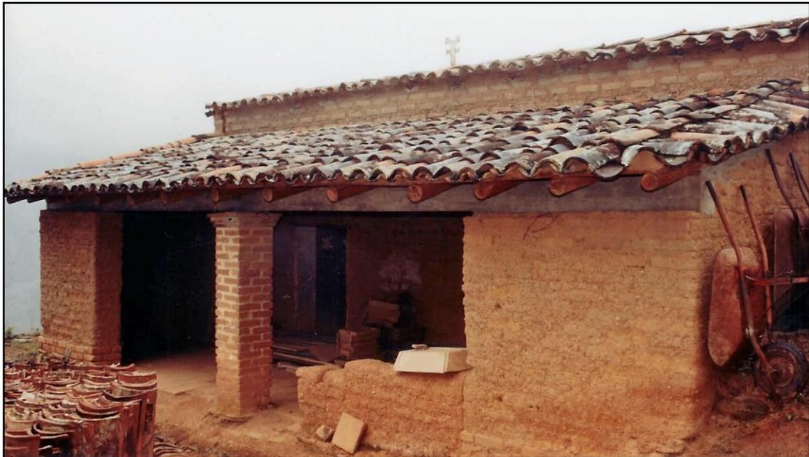
Figura 5.1. “Vivienda mestiza” El pórtico de la vivienda fue reconstruído con tabique rojo industrializado y tiene una trabe de concreto armado para recibir la techumbre que está hecha con morillos de pino y teja fabricada en la región; aun así no pierde su belleza. (f.a.)
