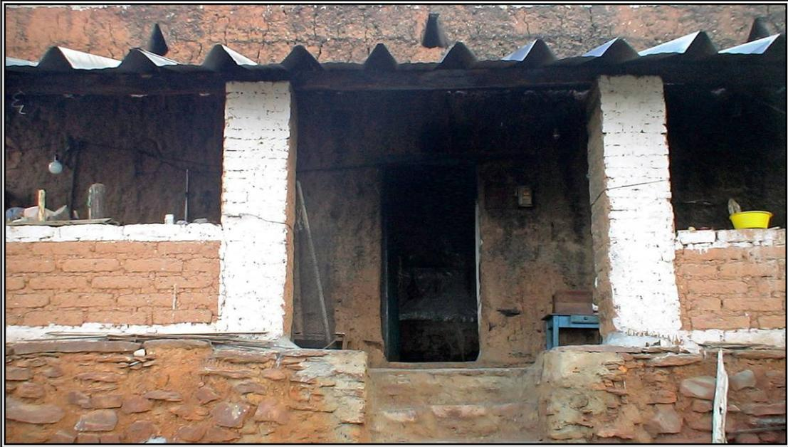
Figura 5.18. Vista al oriente de la “vivienda mestiza”. Donde los elementos formales se han conservado: cimientos de piedra del lugar, muros y columnas de adobe. Solo se ha cambiado la techumbre que otrora era de tejas de barro, ahora se ha colocado lamina metálica. En este cuarto donde anteriormente se realizaban todas las funciones de habitabilidad de la familia, ahora solo es usado como cocina – comedor. (f.a.)
