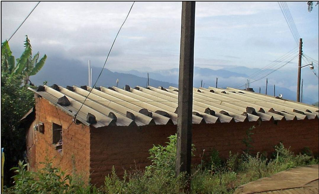
*Figura 5.3. Vivienda de construcción reciente. Los muros han sido realizados con adobe algunos refuerzos en cerramiento se han hecho con concreto armado; la techumbre es de lámina metálica. En la figura se aprecia la acometida de la instalación eléctrica. Esta construcción comparte el predio con una vivienda que fue erigida años atrás*
