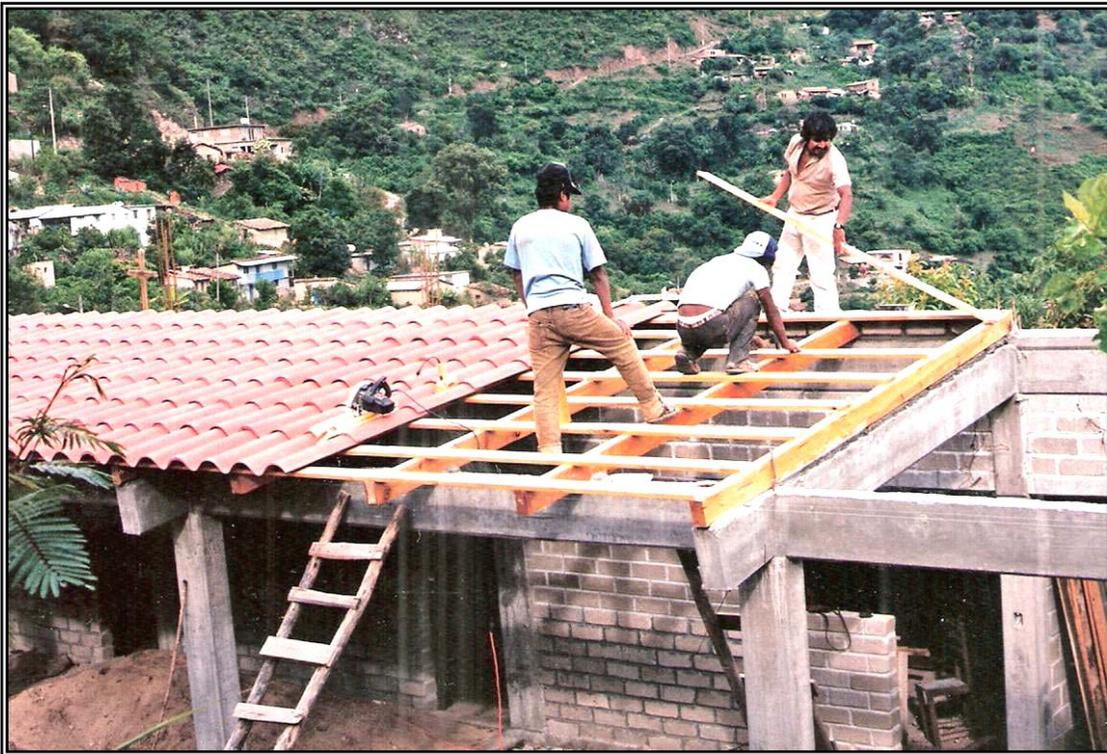
Figura 5.11. En esta fotografía aparecen las traveses de concreto armado que servirán de soporte de la cubierta del corredor de la vivienda; la pendiente lograda es de  $20^\circ$  con respecto al nivel de la losa. Sobre las traveses de concreto se colocan las vigas de madera que finalmente soportarán la cubierta de lámina de asbesto cemento que tienen la apariencia de tejas de barro.
