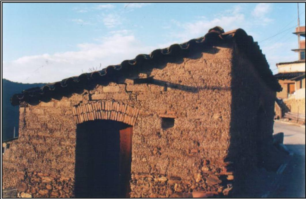
Figura 4.16. Vivienda en Yalalag construida en la primera mitad del siglo XX, donde se aprecia un vano para ventana determinado por el tamaño del largo de un tabique rojo y la altura es apenas de lo que mide el ancho de un sillar de adobe. El vano para la puerta tiene un ancho de 90 cm. Nótese el arco rebajado que se realizó con dos hileras de tabique rojo recocido. El desplante de los muros de adobe se realizó de piedra, solucionando la diferencia de niveles realizando un escalonamiento. (f.a.)
