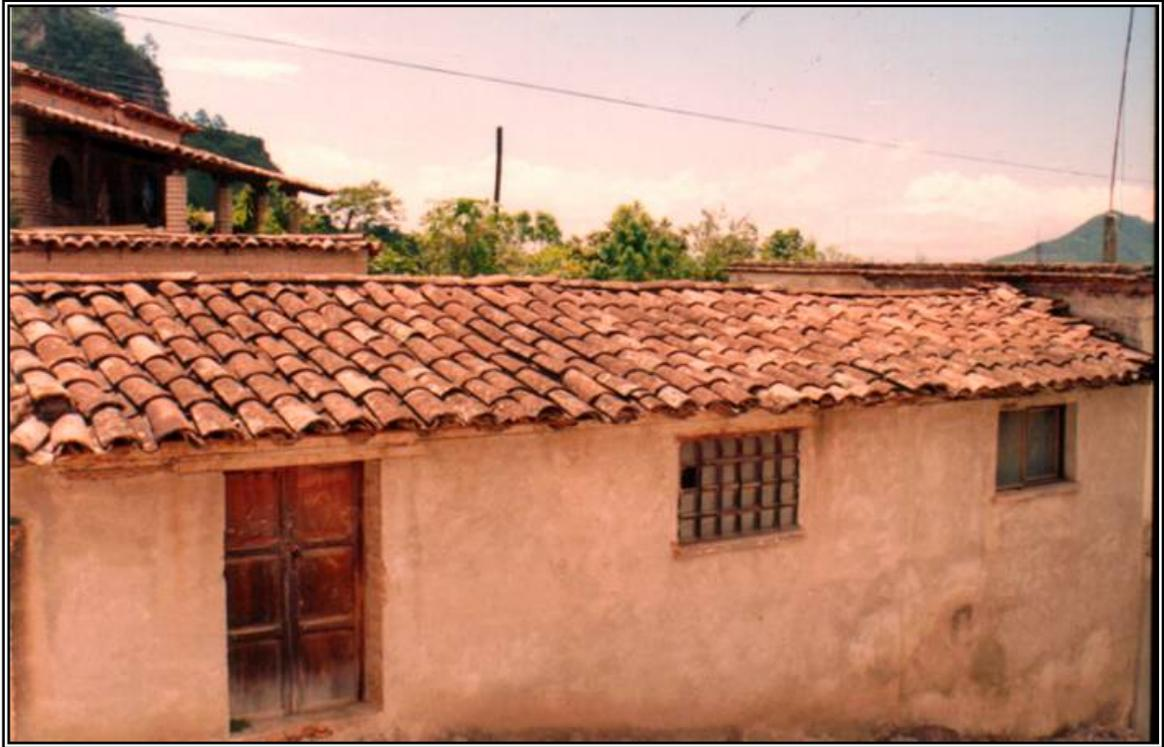
Figura 4.17. Vivienda en la comunidad de San Francisco Cajonos. La techumbre es de teja de barro rojo recocido y estructura de madera. También se puede ver el repellado con estuco de cal. Cuenta con vanos de grandes dimensiones, si se compara
