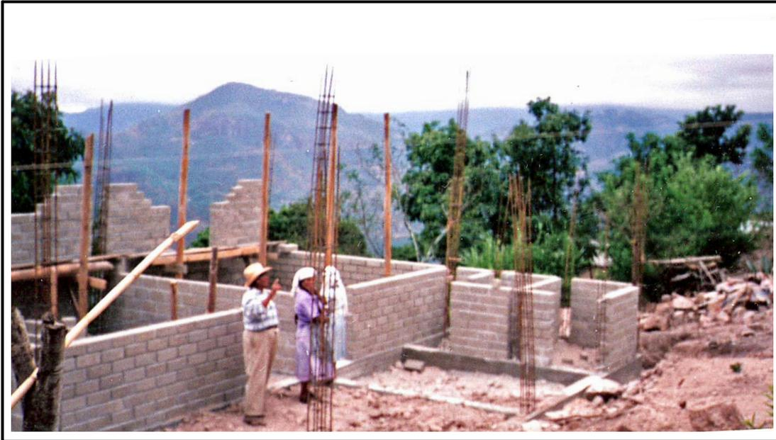
Figura 5.9. En esta fotografía ya se pueden ver los muros de tabicón de cemento arena que conformaran la vivienda;
