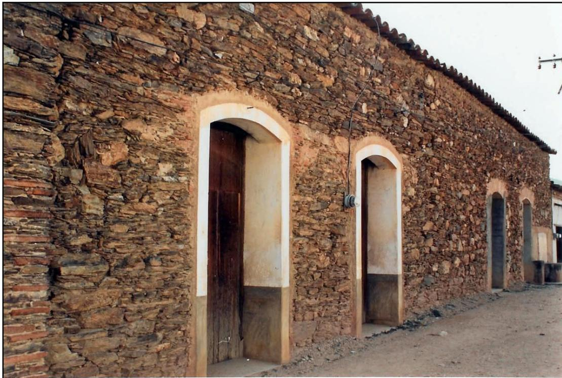
Figura 5.2. “Vivienda mestiza” en Yalalag. Los muros han sido realizados con piedra, la cubierta es de teja roja. Son escasos los ejemplos de este tipo de vivienda, por lo que contrasta con la constructividad y la función que se desarrolla dentro de la misma.
