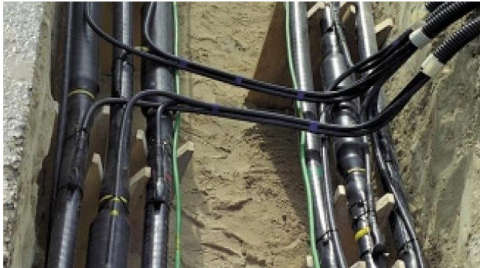
**Figura 4.7 – Arreglo para un sistema de cables de transmisión en conexión cruzada.**
