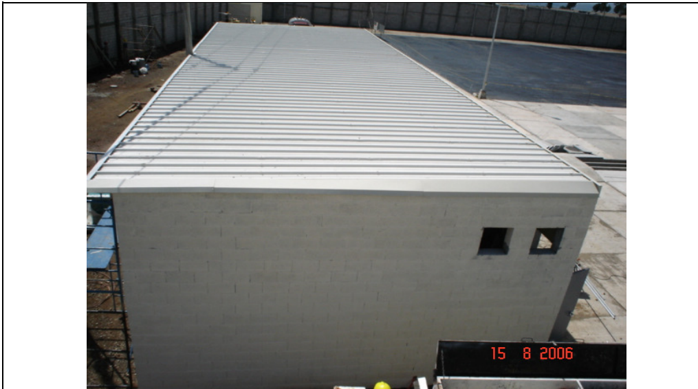
FOTO No.7.- Vista superior de la caseta de control, techumbre 100% completada.
