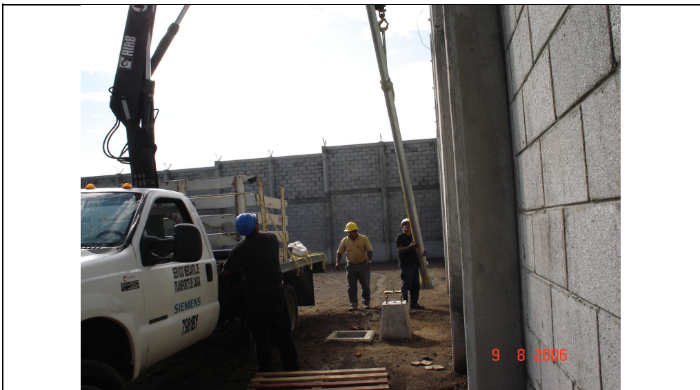
FOTO No.1.- Montaje de postes para alumbrado perimetral. Se tienen listas todas las ciemntaciones, ducto perimetral y registros eléctricos.
