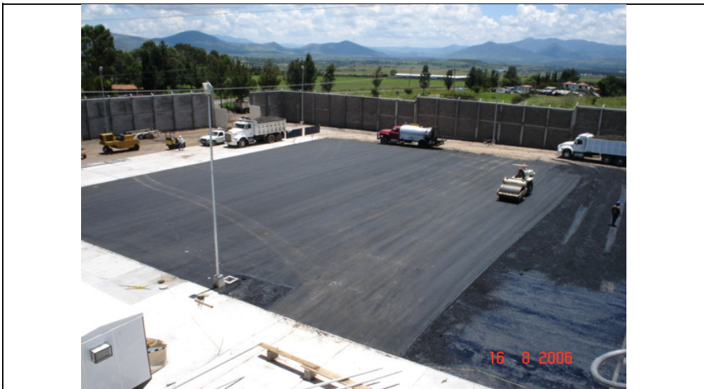
FOTO No.10.- Colocación de carpeta asfáltica, iniciando por el lado oriente de la subestación.
