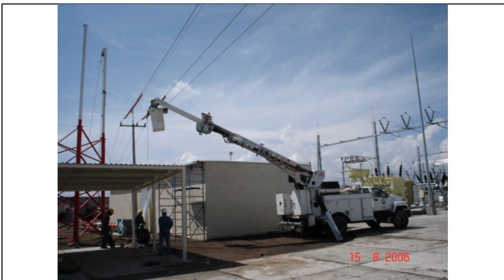
FOTO No.2.- Aislamiento de línea existente para montaje de torre de comunicación.
