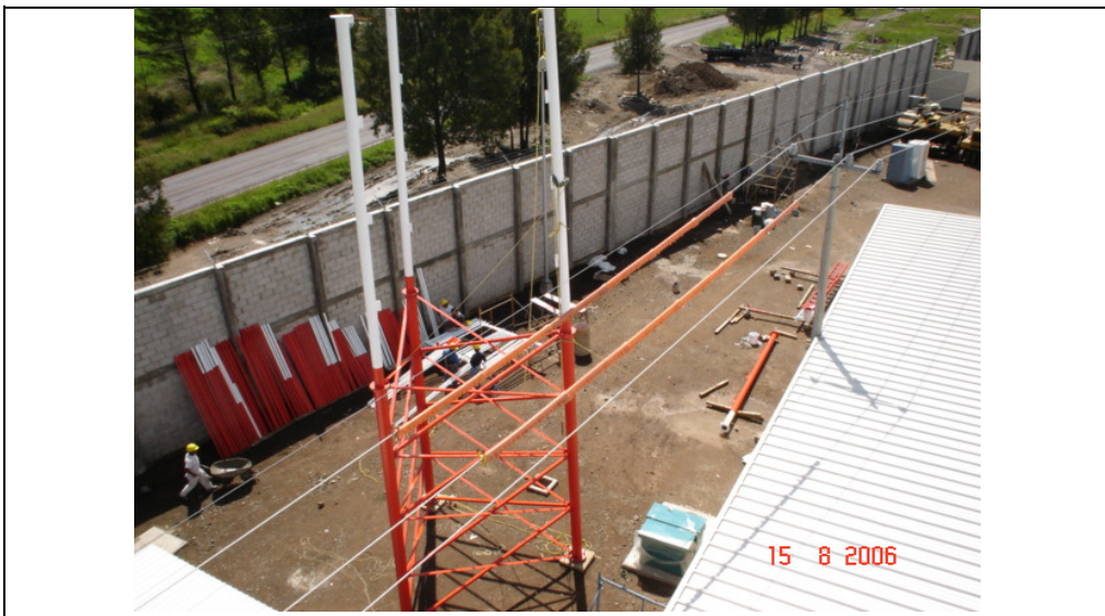
FOTO No.3.- Avance en el montaje de torre de comunicación.
