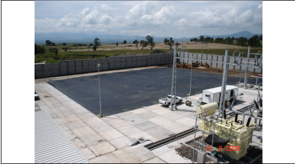
FOTO No.9.- Riego de impregnación en la superficie de pisos de asfalto.
