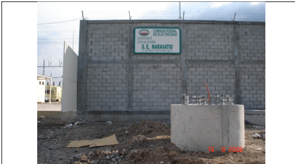
FOTO No.5.- Letrero de identificación instalado conforme a proyecto.
