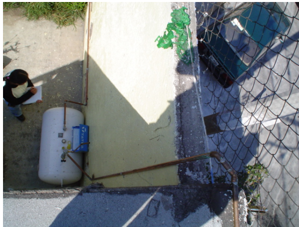
Jardiin de niños Jose Eduardo Gorostiza: tanque de gas de 300 litros incluye medidor regulador válvula de globo conexión de tubería de cobre tipo “1” de 13mm de diámetro con codo de 90 y de 13 mm de diámetro.
