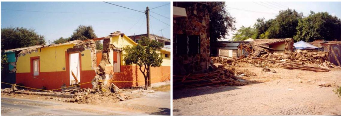
**Figura 2.21 Daño parcial y total en edificaciones de adobe sin liga entre muros**
