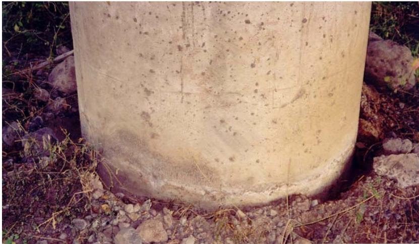
**Figura 2.5 Evidencia del movimiento en los apoyos del puente “Manzanillo”**
