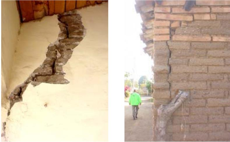
**Figura 2.10** Agrietamiento vertical en esquinas de muros de mampostería por ausencia de elementos que los ligan a muros transversales
