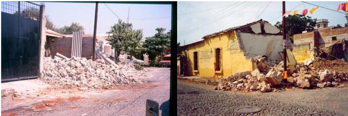
**Figura 2.25 Construcciones con materiales combinados y falla de los muros**
