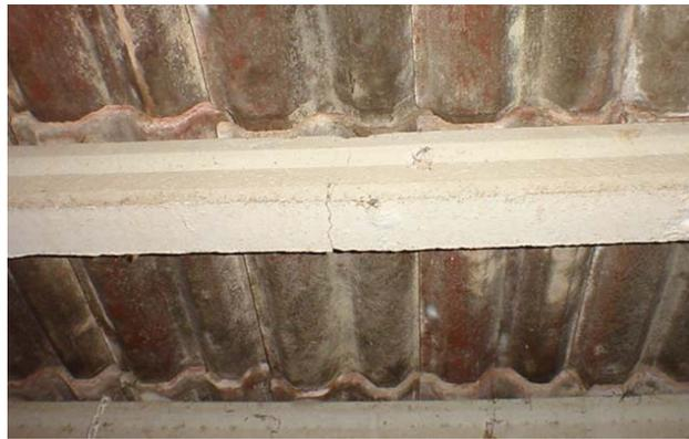
**Figura 2.11** Agrietamiento por flexión en viguetas de concreto reforzado
