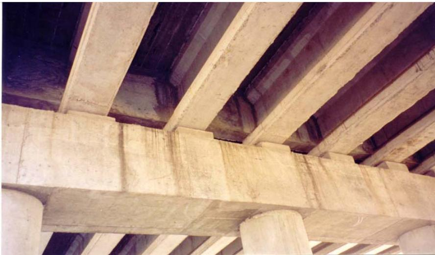
**Figura 2.3 Desfase de su posición original de las vigas precoladas del puente “Manzanillo”**
