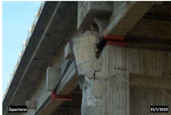
**Figura 2.20 Daño severo en el tope del puente Coahuayana**
