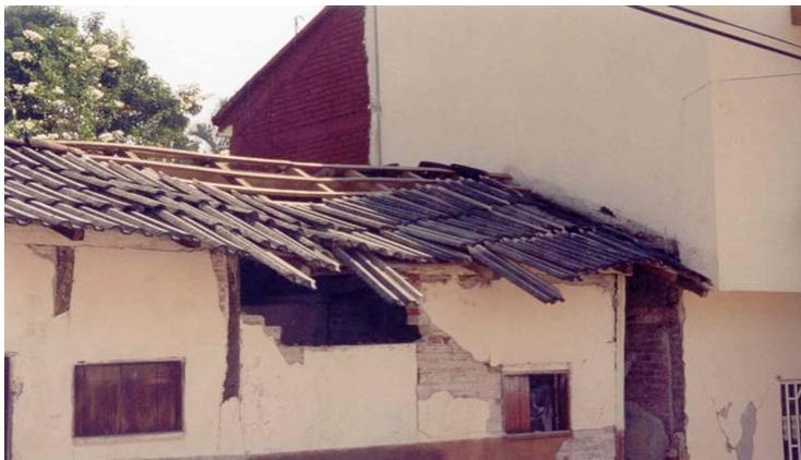
**Figura 2.8 Daños en exterior e interior de una vivienda con daño tipo III**
