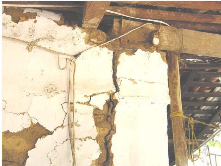
**Figura 2.16 Daño en un muro de adobe a causa de una mala liga del castillo y la dala de cerramiento**
