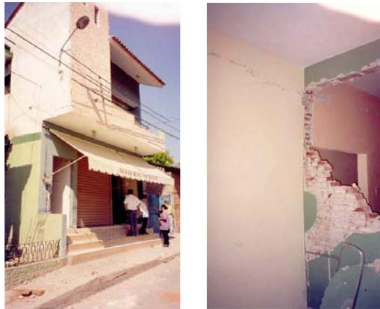
**Figura 2.7 Daños en exterior e interior de una vivienda con daño tipo III**
