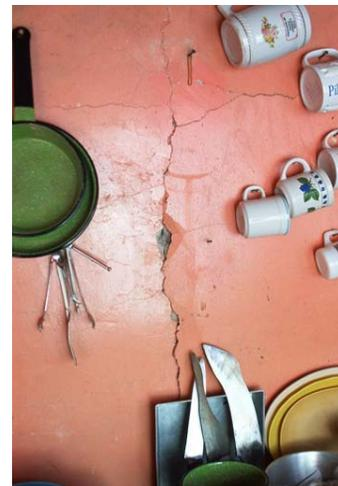
**Figura 2.12 Agrietamiento diagonal de muros**
