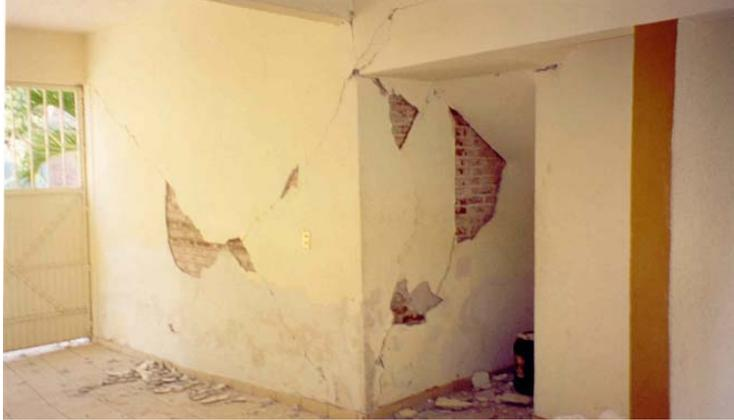
**Figura 2.6 Muros dañados en el interior de una vivienda con daño tipo II**
