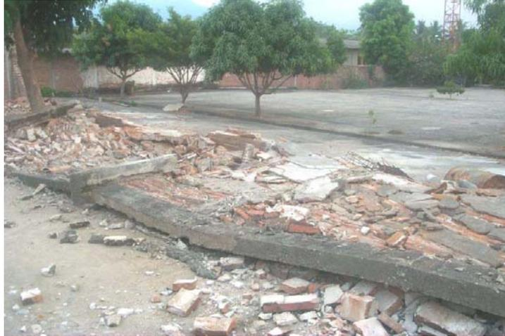
**Figura 2.17 Bardas de mampostería con defectos en el refuerzo**
