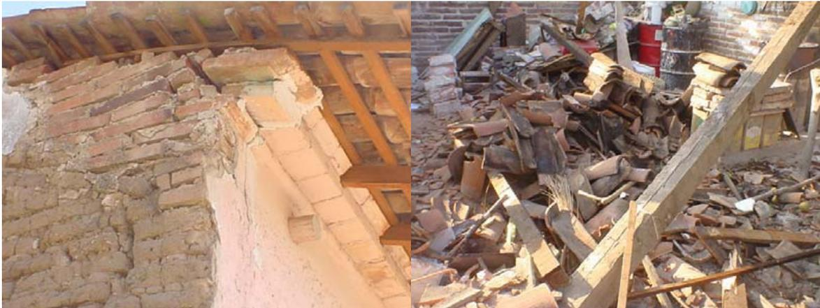
**Figura 2.13 Corrimiento de los rollizos de madera que soportaban el sistema de techo y colapso total de la techumbre**
