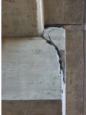
**Figura 2.4 Daño en el tope del puente “Manzanillo”**
