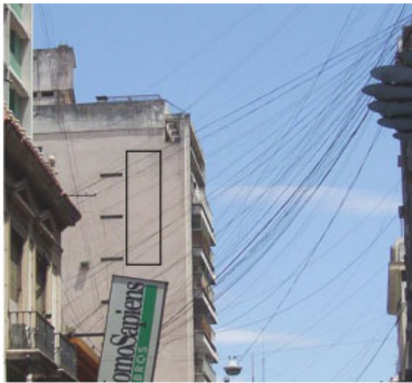
CABLES EN LA CIUDAD
