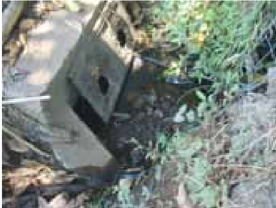
Alcantarilla en el km 4+840
