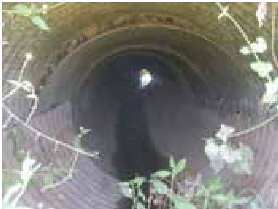
Alcantarilla en el km 4+974.25
