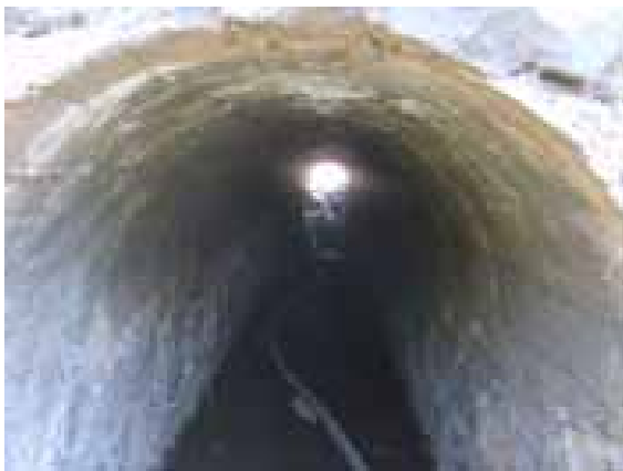
Alcantarilla en el km 4+380
