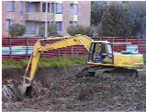
figura 3.3.4 Proceso de excavación (ref 15)
