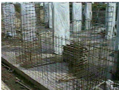
fig 1.2.3 Losa de cimentación (ref 15)
