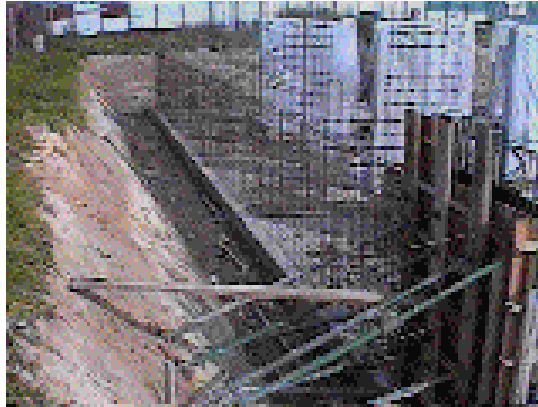
fig 1.2.4 Cajón de cimentación (ref 15)
