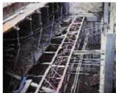
figura 3.3.1 Excavación apuntalada (ref 15)
