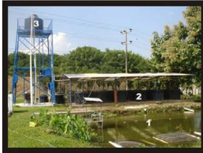
Figura 2. Sistema de recirculación del Área de Crianza del CEIEGT. Con el número uno se señala el estanque rústico, con el dos las tinas y con el tres el tinaco de almacenamiento
