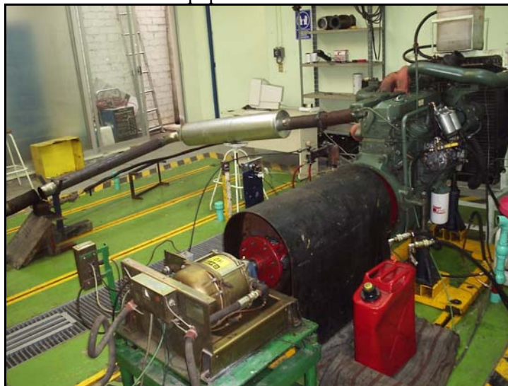
Figura 4.9 Instalación del equipo.
