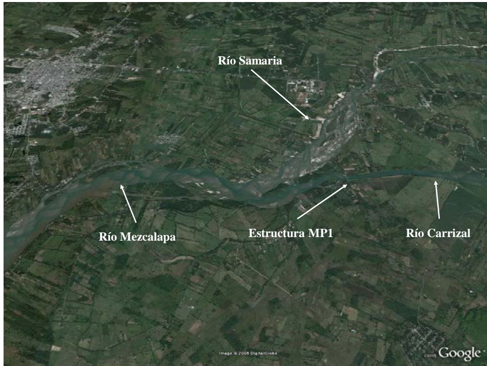
Figura 1.2 Sitio donde se desea construir la estructura de Control MP1
