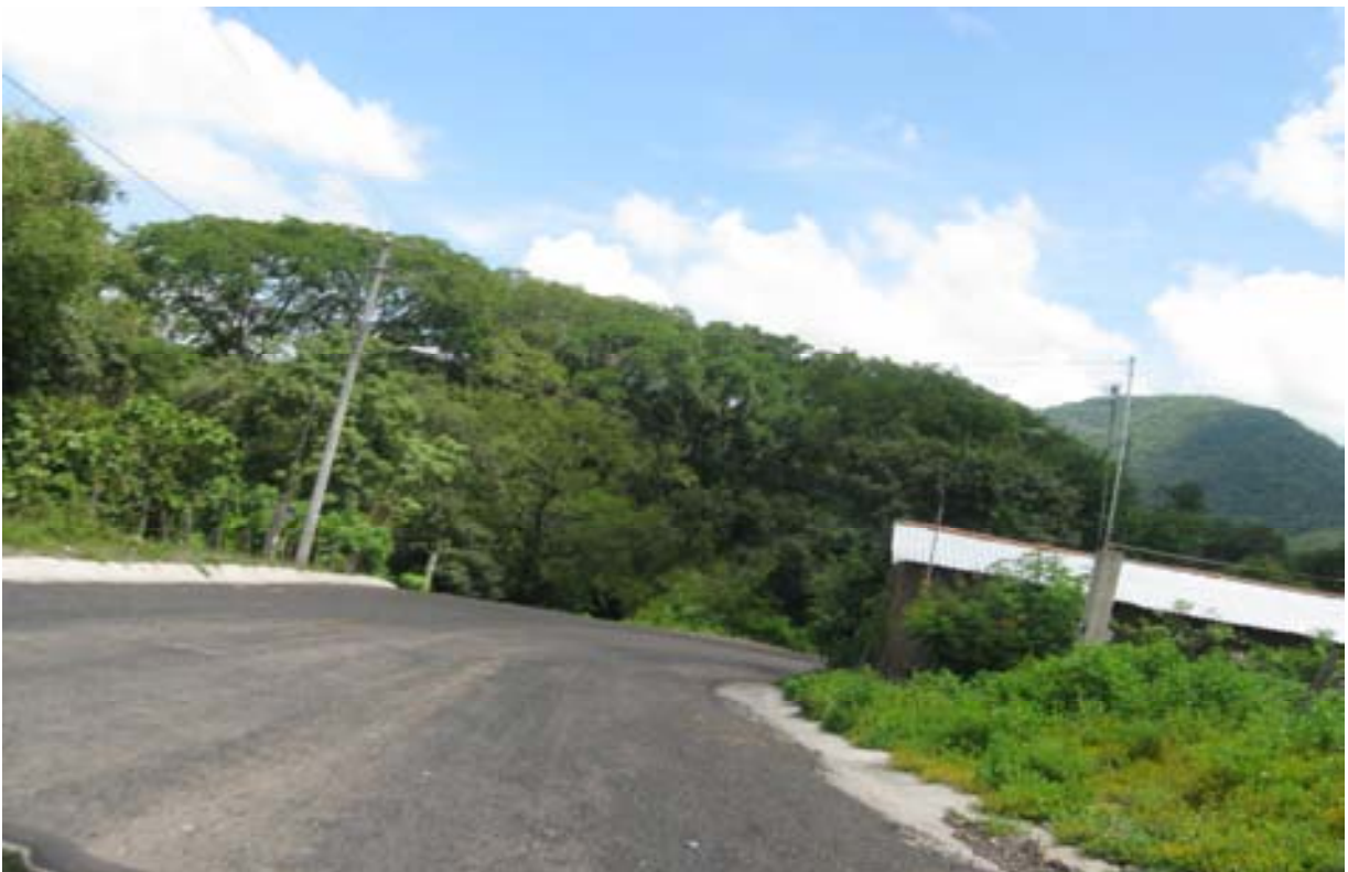
Fig. 5.6. Falta de balizamiento del camino.
