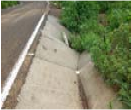
Imagen 10, Localización de la alcantarilla de losa. Km. 7+606 Fuente: propia
