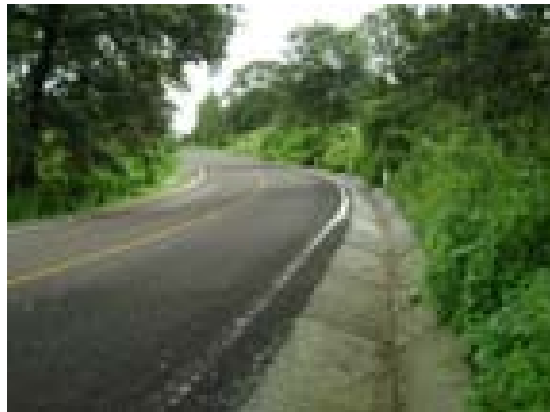
Imagen 7, Localización de cuneta y bordillo Km. 7+ 860 Fuente: propia
