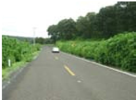
Imagen 9, Tipo de vegetación que se encontró en el camino que afecta las obras de drenaje, así como la visibilidad de los usuarios. Km. 7+ 520
