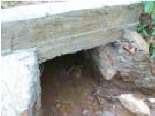
Imagen 12, Localización de alcantarilla de losa. Km. 7+815 Fuente: propia
