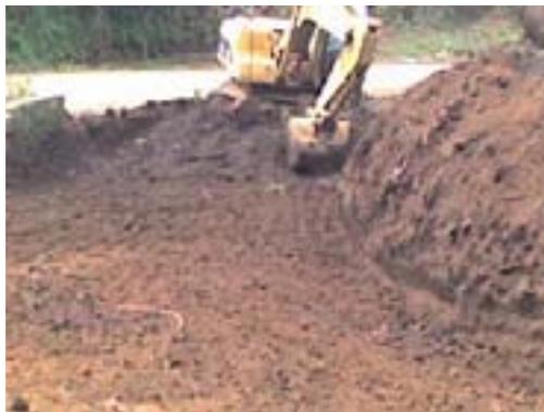
**Foto 5.0 Corte con Excavadora**
