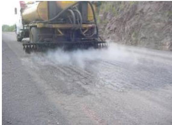
**FOTO 5.7 Colocación de Riego de Liga**
