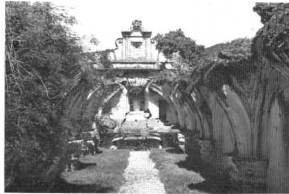
b Debris filled nave Nave llena de escombros
