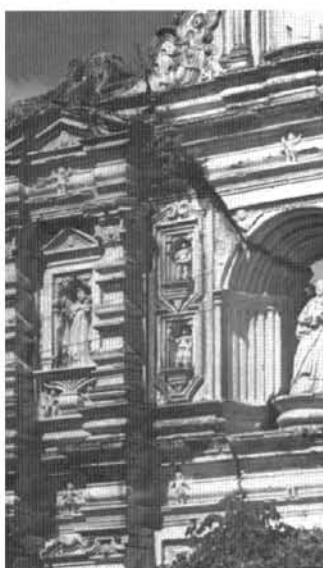
b Detail of upper façade, 'cushion' pilasters Detalle del cuerpo superior, pilastras almohadilladas
