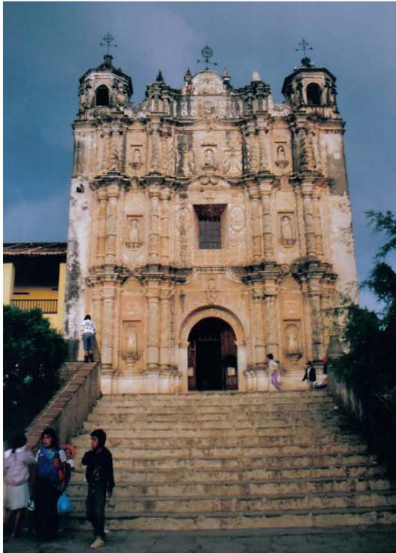
2. Fachada antes de la restauración de 2006 (foto: GUG).
