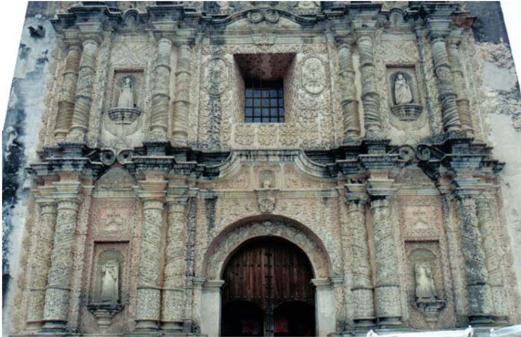
9. Entrada al templo con doble arco de medio punto (foto: GUG).
