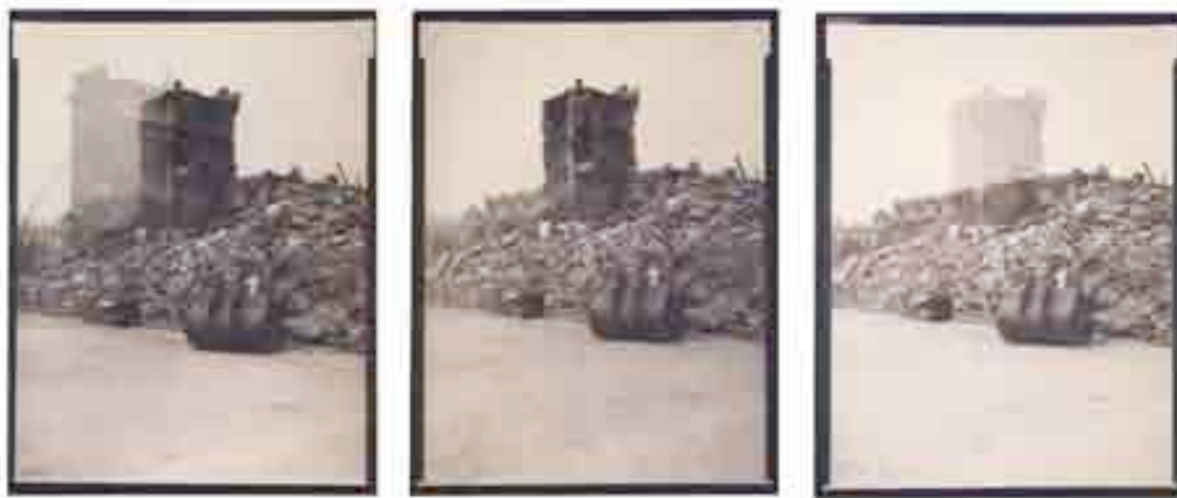
Fig. 16 Martí Llorens, Enderroc final de l'edifici Icaria 6-8, sèrie Poblenou, Barcelona, 1989
