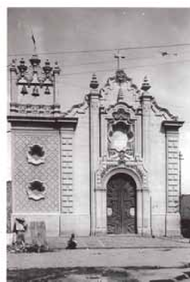
FIG. 75. La Candelaria de los Patos con fachada neocolonial. Manuel Ramos (ca. 1930).
