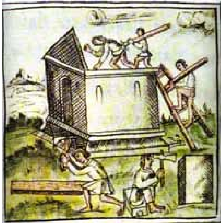
FIG. 104. Códice florentino . Indios construyendo una capilla.
