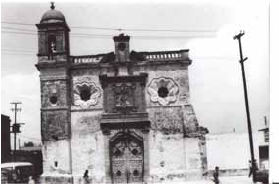
FIG. 63. San Antonio Tomatlán (ca. 1965). Nótese la transformación de la torre y el remate.
