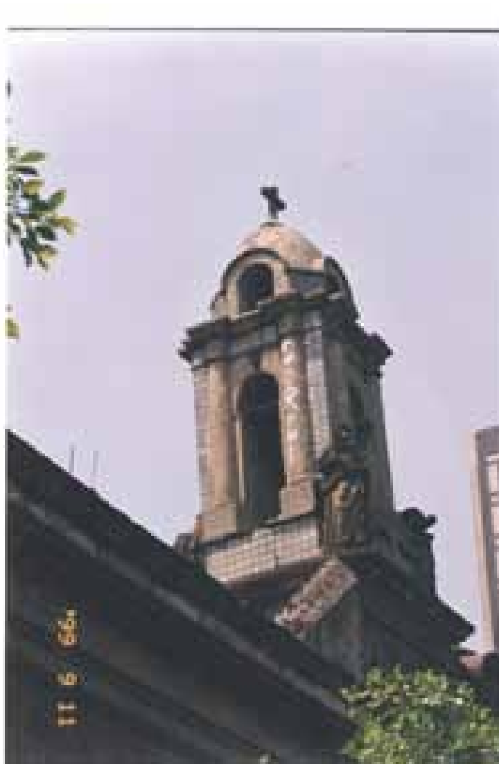
FIG. 54. San Salvador el Seco. Torre. RGT (1999).
