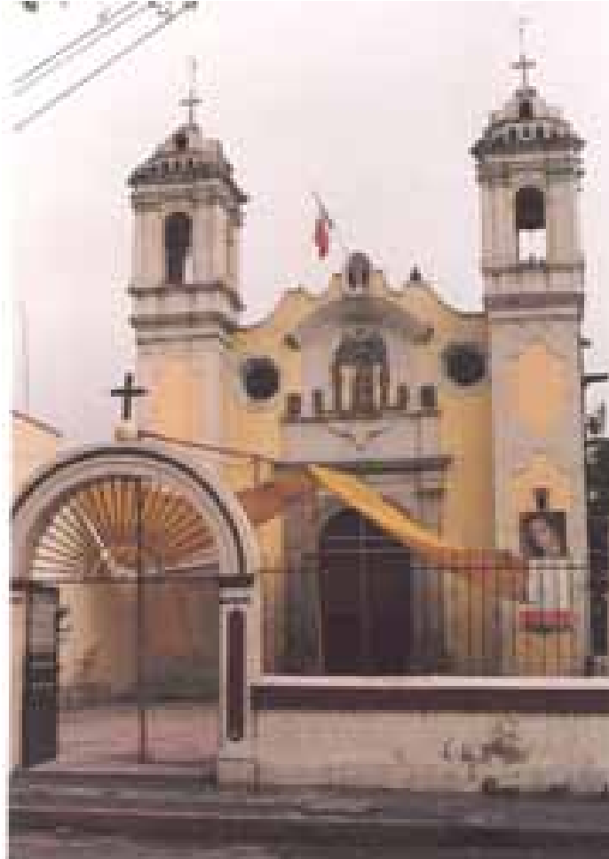
FIG. 43. Santa Ana. Fachada. RGT (2006).
