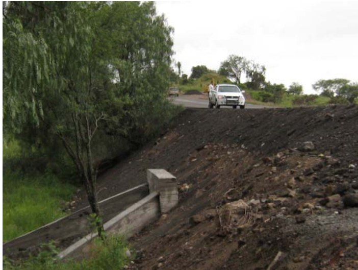
Fig. 3.11 Km 146+600 vista hacia Morelia.
