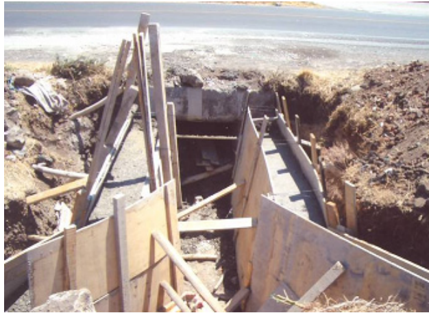
Fig. 5.4 Construcción de alcantarilla tipo losa.
