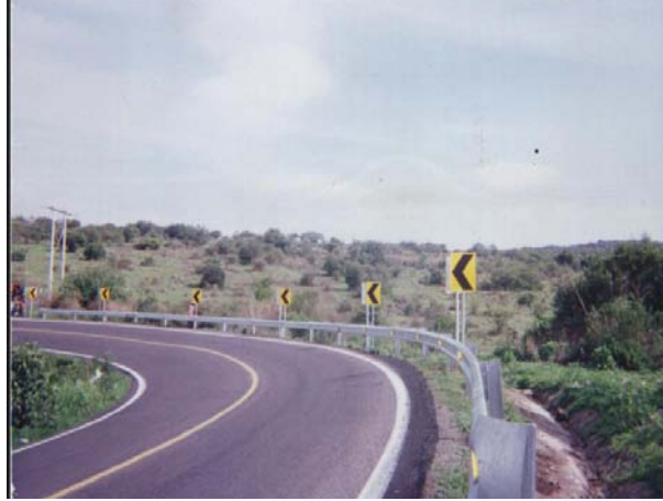
Fig.5.18 Instalación de defensas metálicas.
