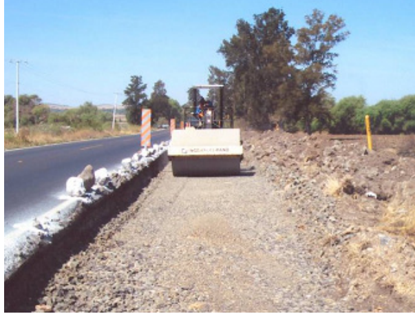
Fig. 5.5 Formación y compactación de la sub-base
