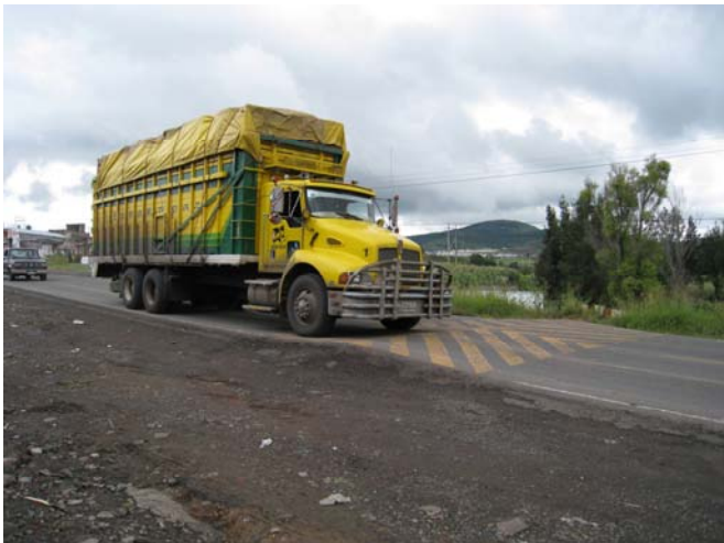
Fig. 3.14 Km 144+650 vista hacia Morelia.
