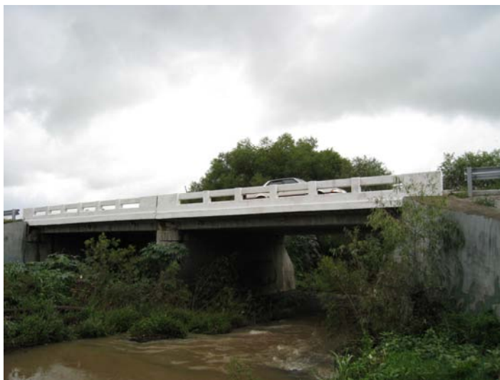
Fig 3.12 Km 142+300 vista hacia Morelia.
