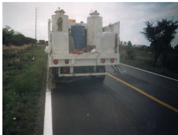
Fig. 5.10 Aplicación de marcas en el pavimento.
