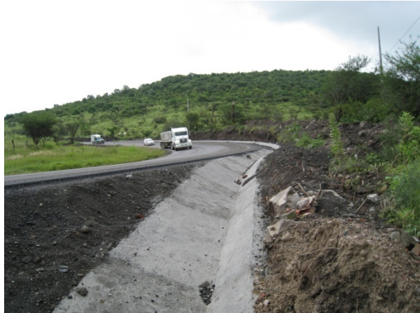
Fig. 2.1. Construcción de una cuneta
