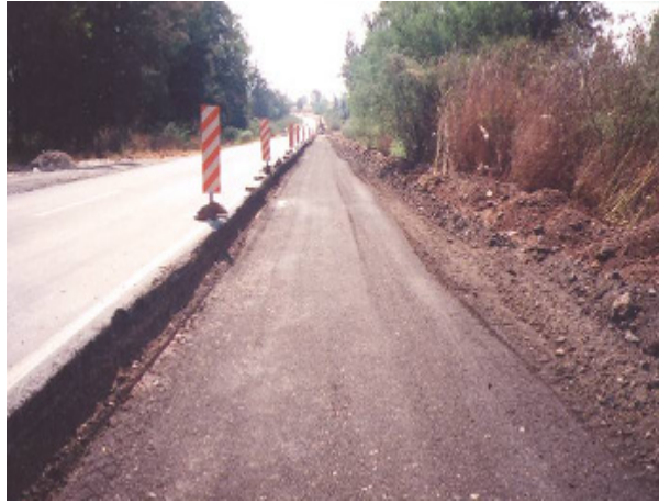
Fig. 5.6 Base hidráulica terminada.
