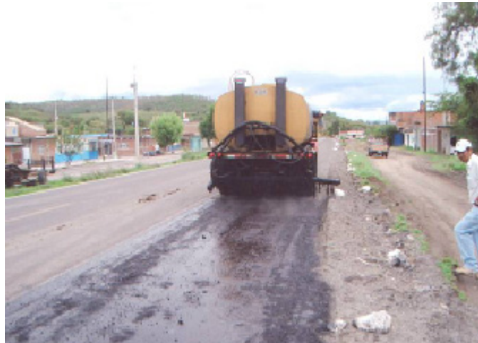
Fig. 5.7 Elaboración del riego de impregnación.
