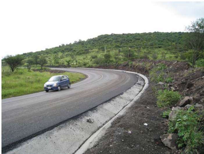
Fig. 3.10 Km 150+100 vista hacia Zinapécuaro.
