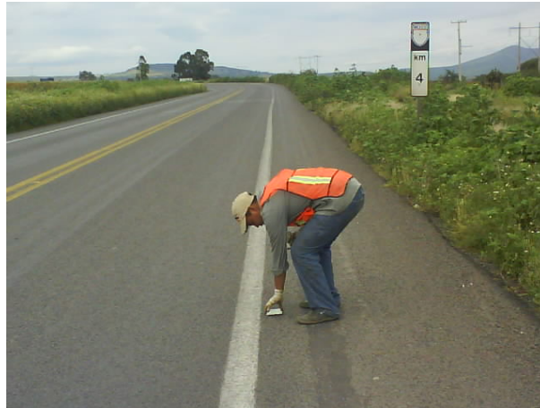
Fig. 5.11 Instalación de botones retrorreflejantes.
