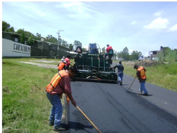
Fig.5.9 Elaboración y tendido de la carpeta asfáltica con finisher.
