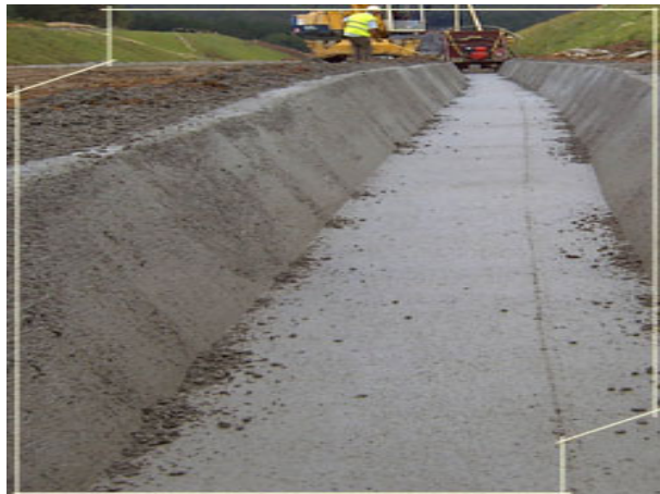
Fig. 2.2. Construcción de una contra cuneta
