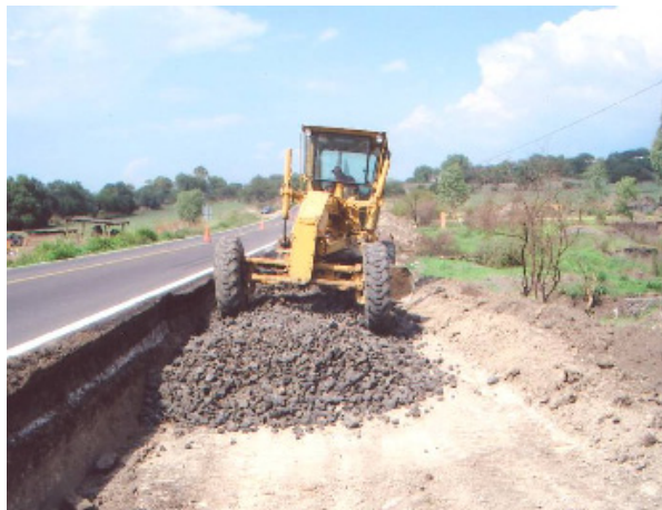
Fig. 5.3 Formación de la capa subrasante.
