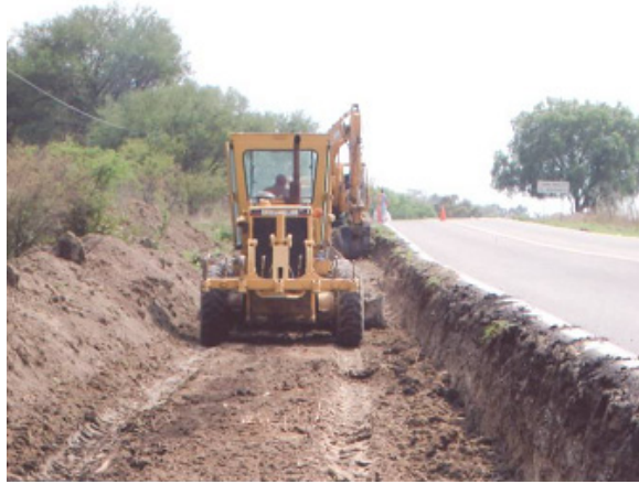
Fig. 5.2 Formación del cuerpo del terraplén
