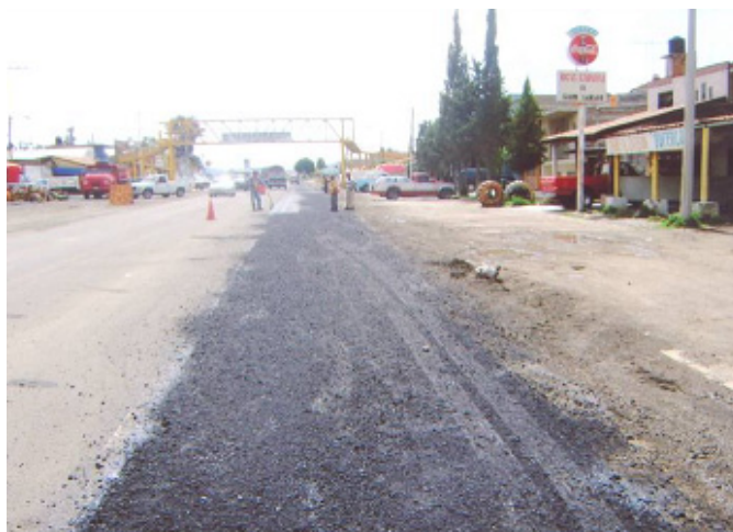
Fig. 5.8 Elaboración del riego de liga.
