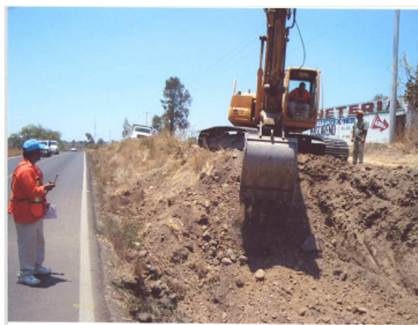
Fig. 5.1 Despалme y desmonte del terreno
