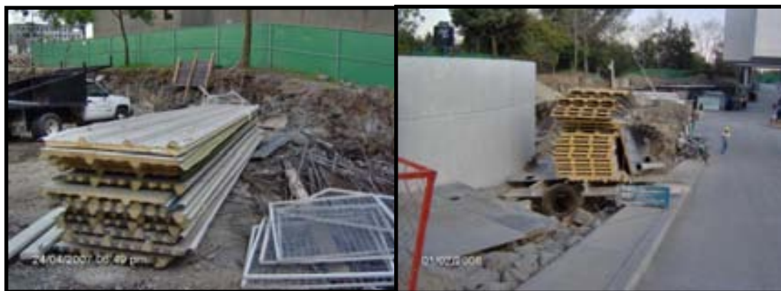
Figura 3.10: Residuos producto del desmontaje.
