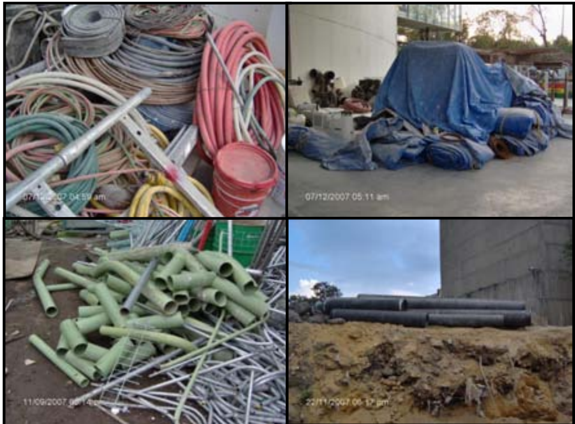
Figura 3.17: Almacenamiento de PVC.
