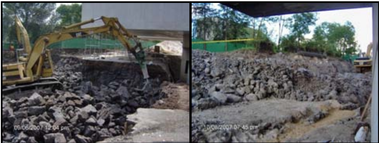
Figura 3.20: Generación de residuos de excavación.
