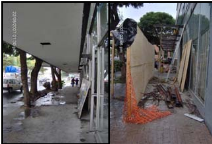
Figura 3.4: Edificio de Oficinas remodelación Marquesina.
