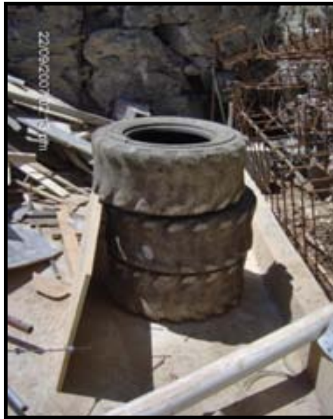
Figura 3.15: Almacenamiento de llantas.
