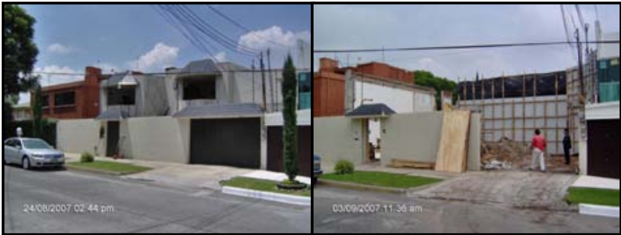
Figura 3.3: Vivienda Residencial de demolición.
