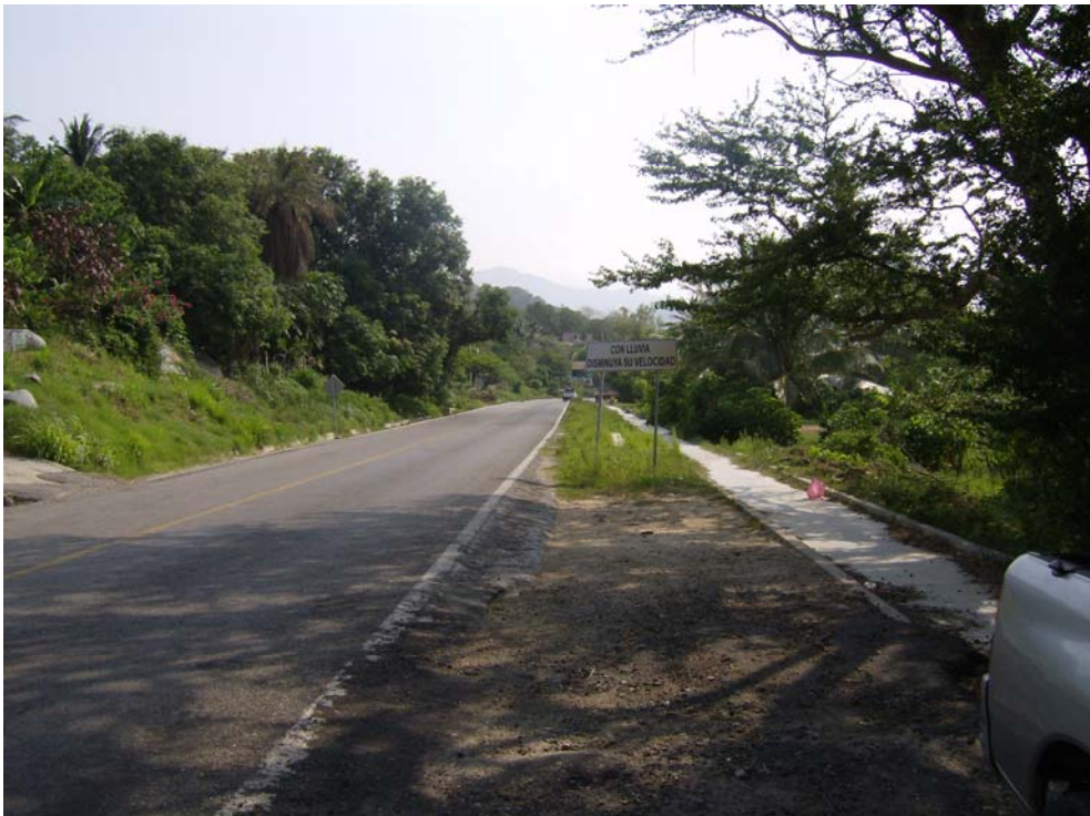
Zona que se inunda por el desbordamiento de río Lagartero impidiendo el libre Tránsito de vehículos Carretera federal N. 195.
