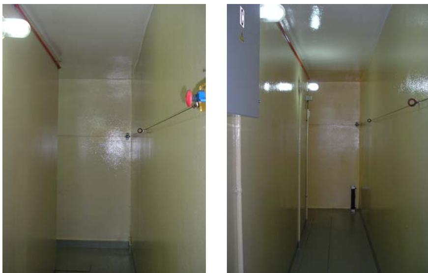
Figura 38. Laberinto de acceso con muros de 2.10 m de espesor y piso falso de seguridad
