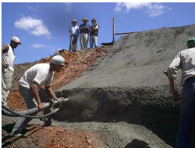
Imagen 3.12.- Ejemplo de Aplicación del Sistema de Concreto Lanzado Fuente: http://es.wikipedia.org/wiki/Gunitado
