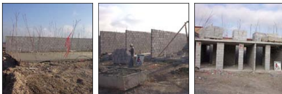
Figuras 21, 22 y 23. Producción en cadena, en la que se intervienen distintos frentes de manera simultánea, alcanzando diferentes niveles de avance, de acuerdo a la programación de las partidas de la obra.
