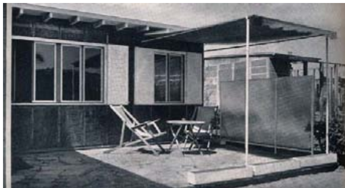
Figuras 16, 17 y 18. Casa prefabricada a base de paneles de obre (1931). Construcción y ensamblaje de paredes (arriba); vista exterior (en medio) y vista desde la terraza (abajo).
