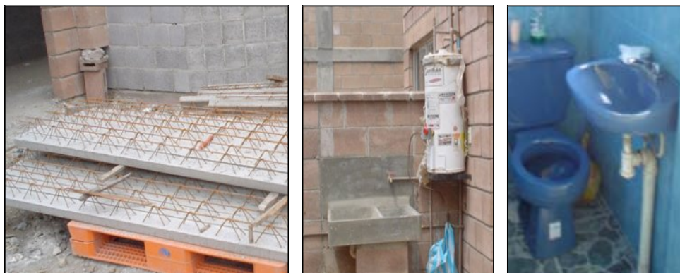
Figuras 26, 27 y 28. Clasificación de los materiales utilizados en obra, de acuerdo a su fabricación y uso.
