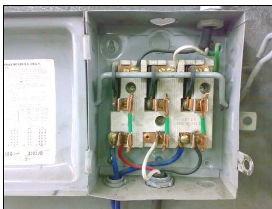
Figura 2.8A. Fusibles puenteados.
