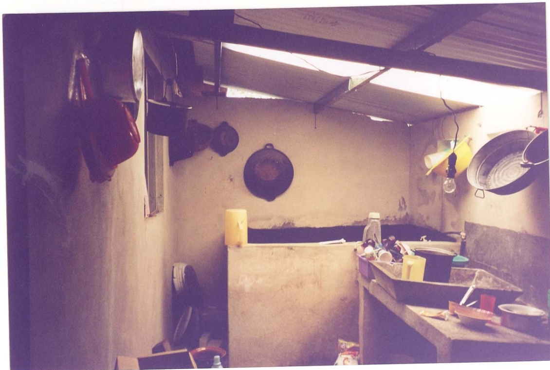
Foto 3.2. Construcción de piletas. Foto Beatriz Méndez.
