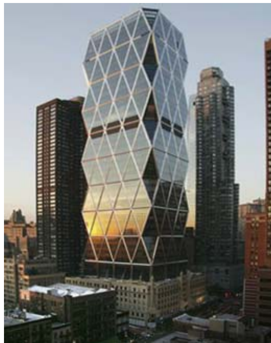
Figura 1.6 Fachada de la Torre Hearst Nueva York, Estados Unidos
