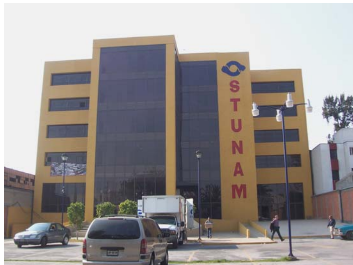
Figura 1.11 Fachada principal del edificio del STUNAM
