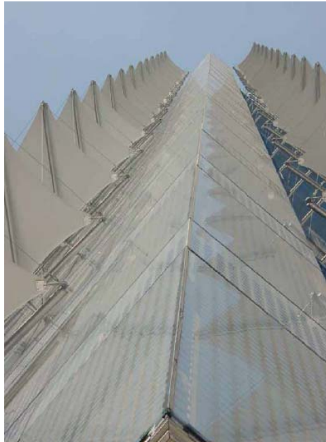
Figura 1.10 Louvers horizontales diseñados para evitar el aumento de calor
