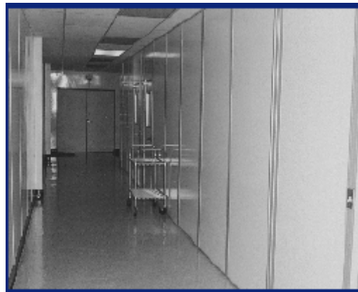
Figura 2.25 Paneles prefabricados unidos
