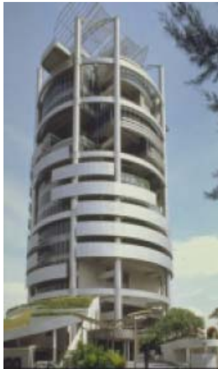
Figura 1.4 Facha de la torre Menara Mesiniega, en Malasia
