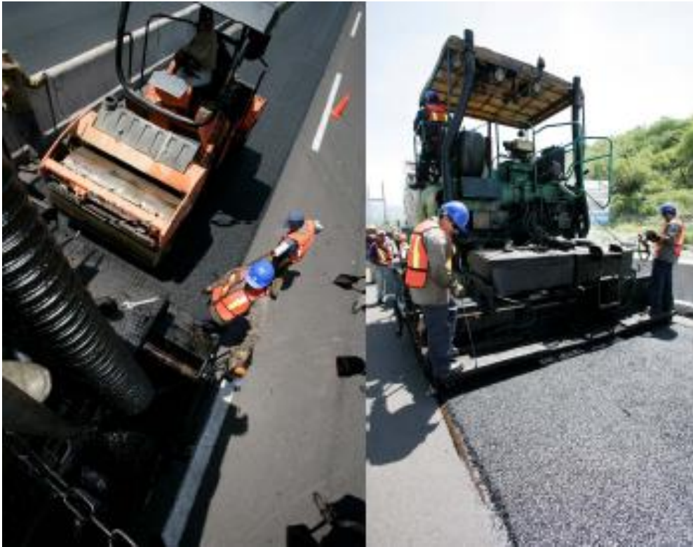
Construcción de Microcarpeta usando el Sistema CASAA
