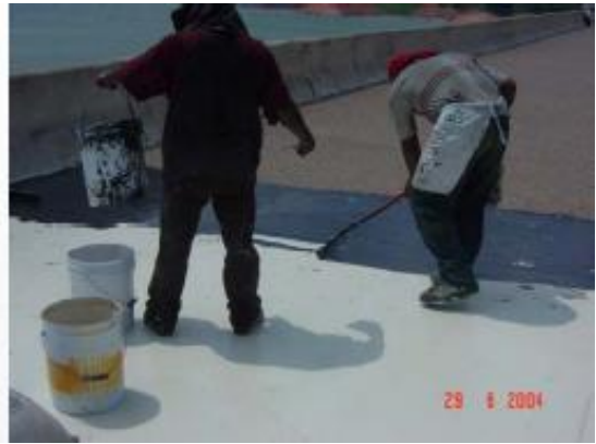
Trabajos previos: Aplicación de resina epóxica.
