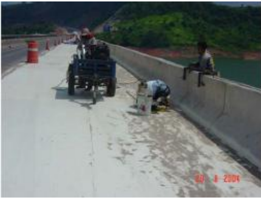
Trabajos previos: Aplicación de resina epóxica.
