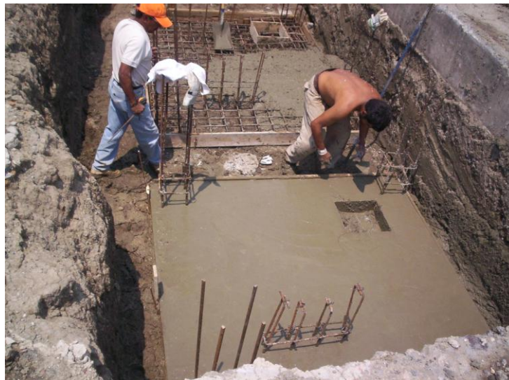
Colado de Losas de Fondo en Cajas de Control y Medición, en Calle 699 y Calle 606.
