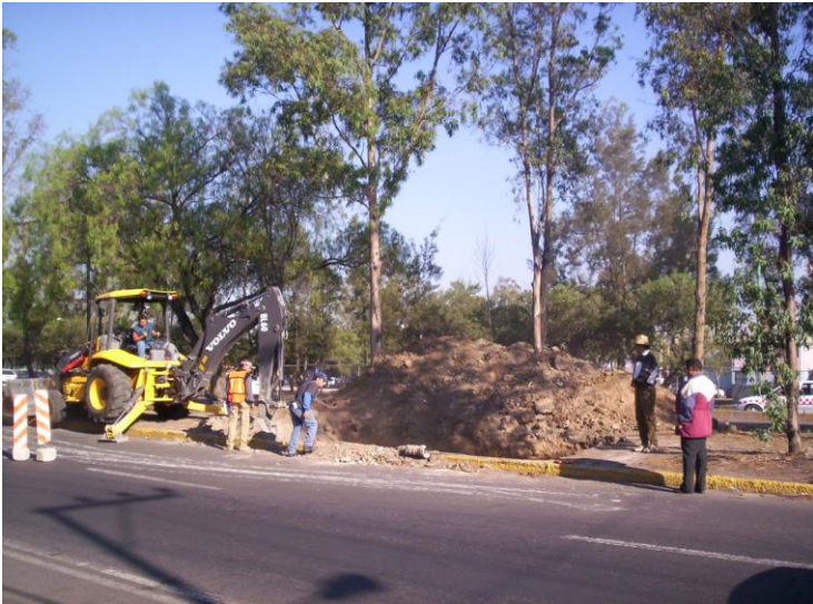
Excavación por medios mecánicos en camellón para construcción de Sitio de Control y Medición, en Av. Texcoco y calle Oriente 11.
