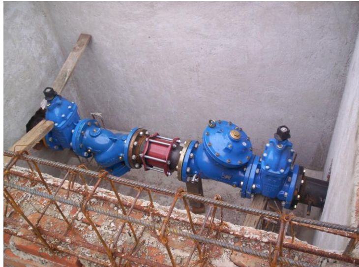
Instalación de piezas especiales de 6" de diámetro, para Sitio de Control en Av. 699 y Calle 606.
