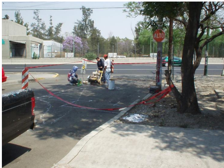
Corte en Pavimento Asfáltico para construcción de Sitios de Control y Medición.
