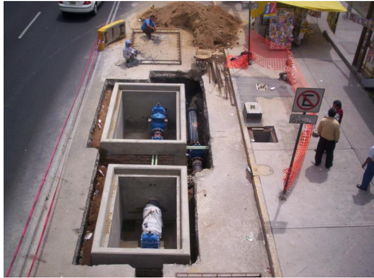
Vista general de la Construcción de los Sitios de Control y Medición, ubicados en Av. 608 y Calle 613 . Sector GAM-38
