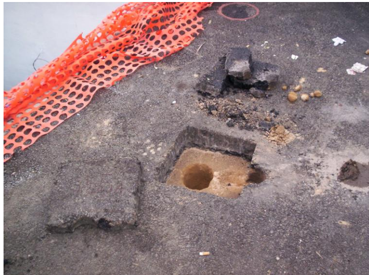
Verificación del grado de compactación en relleno perimetral de cajas de control y medición.
