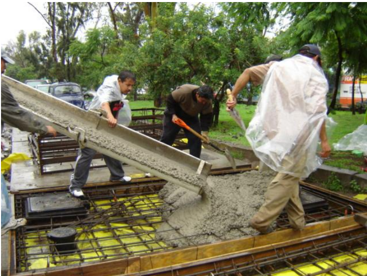
Proceso de colado de losas tapa, para diversos sitios.
