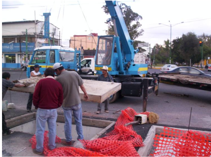
Maniobra para colocar Losas-Tapas en Cajas de Control y Medición de 12" de diámetro.
