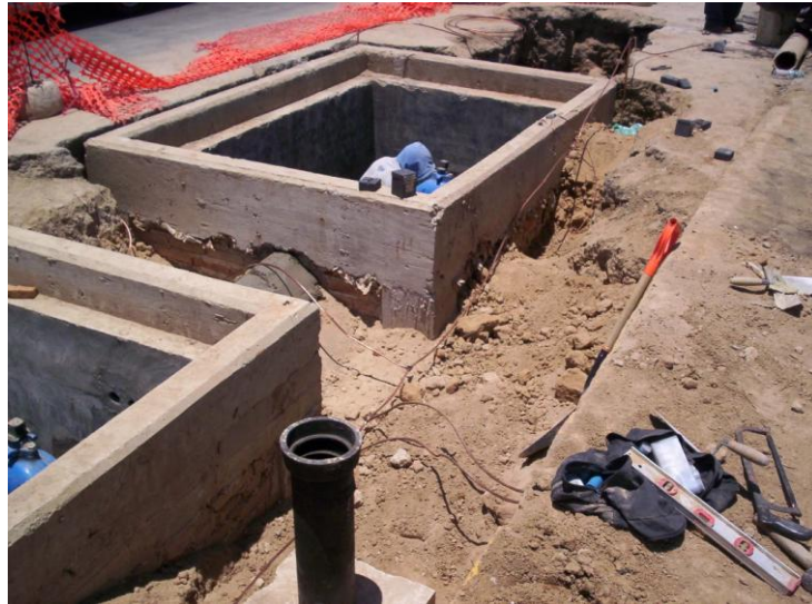
Relleno perimetral, instalación de botas, en Cajas de Control y Medición, en Av. Fco Morazán y Av. 1519. Sector GAM-34
