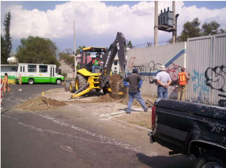
Excavación por medios mecánicos para construcción de Sitio de Control y Medición, en
