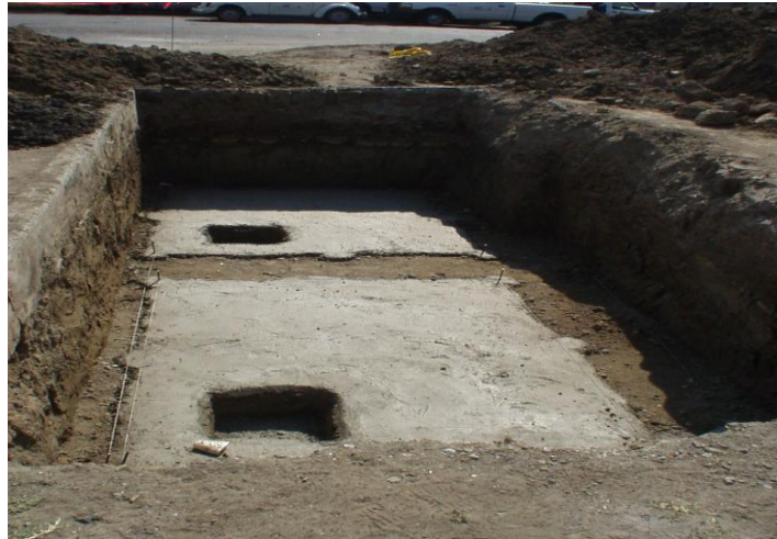
Plantilla de concreto en Cajas de Control y Medición. en Calle 699 v Calle 606.
