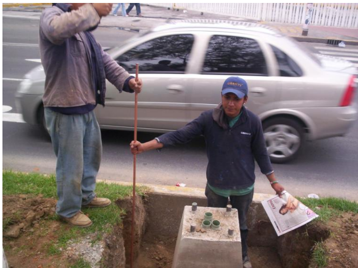
Construcción de Base para Poste, en Loreto Fabela y Acceso 1 al Bosque de Aragón. Sector GAM-37.
