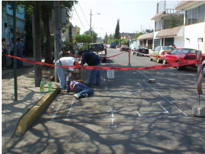
Trazo perimetral para Construcción de Cajas de Control y Medición.
