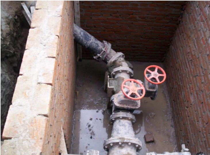
Instalación de Piezas Especiales de 6" de diámetro.
