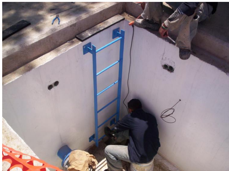
Suministro y fabricación de escalera marina en cajas de control y medición
