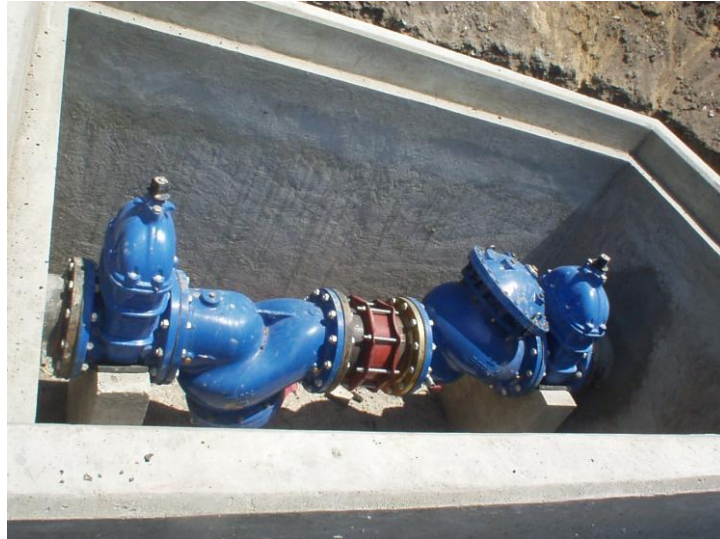
Instalación de piezas especiales de 12" de diámetro, para Sitio de Control en Av. Texcoco y Calle Oriente 11. Sector GAM-40
