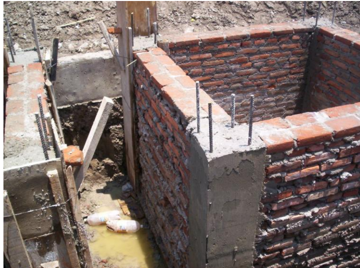
Construcción de Muros de 28 cm en Cajas de Control y Medición, en Av. 608 y Metro Deportivo Oceanía.
