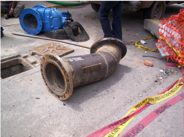
Habilitado de piezas especiales, para realizar pegue de 12" de diámetro.
