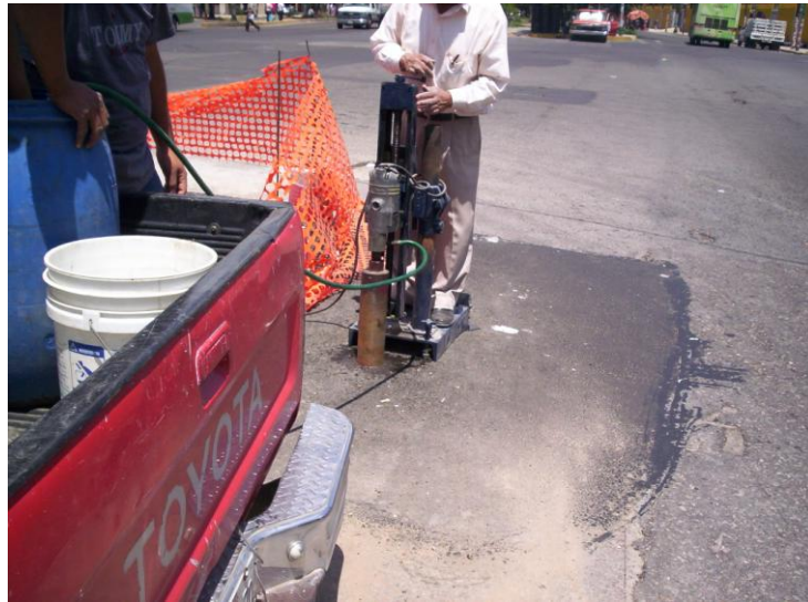
Control de Calidad en asfaltado perimetral de cajas de control y medición.
