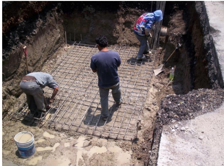
Construcción de losa de Fondo en Cajas de Control y Medición, en Av. 608 y Metro Deportivo
