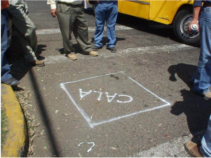
Marca para realizar cala de verificación.
