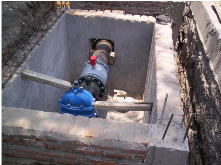
Instalación de piezas especiales de 12" de diámetro, para Sitio de Medición en Av. Texcoco y Calle Oriente 11.
