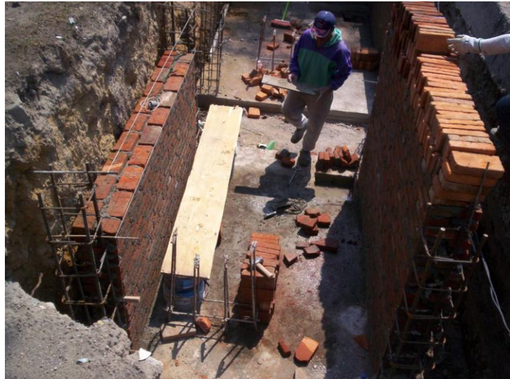
Construcción de Muros de Tabique en Cajas de Control y Medición, en Calle 699 y Calle 606.
