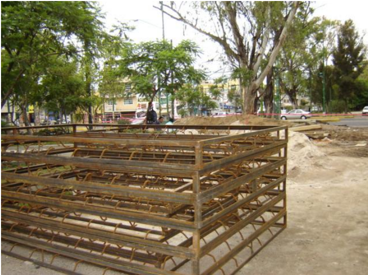
Habilitado de estructuras para colar losa-tapa correspondiente a los Sitios de Control y Medición, en diferentes sectores.
