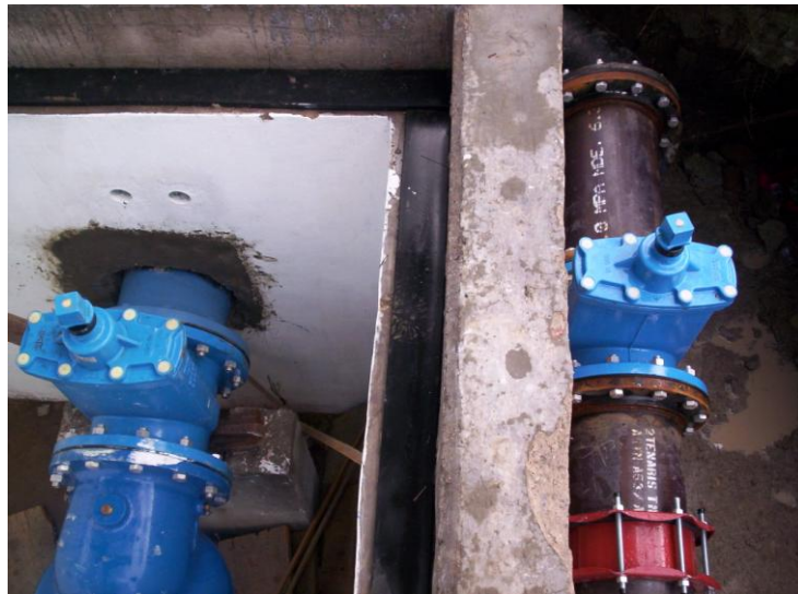
Instalación de Trenes de piezas y By-Pass en línea de 12" de diámetro.
